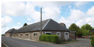
Vue de situation, depuis le nord. Phot. Marie-Laure Monnehay-Vulliet IVR22_20158000672NUC2A
