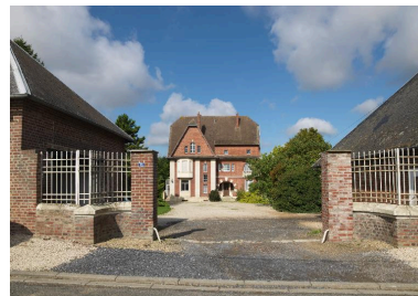
Vue de la cour et du portail. Phot. Marie-Laure Monnehay-Vulliet IVR22_20158000668NUC2A
