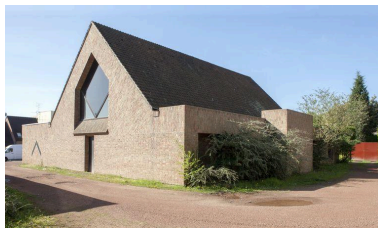
Élévation postérieure de l'église et flanc droit. Phot. Pierre Thibaut IVR31_20155900654NUCA
