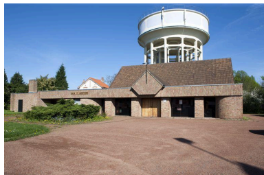
Élévation antérieure de l'église. Phot. Pierre Thibaut IVR31_20155900653NUCA
