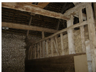
Vue intérieure de la grange. Phot. Inès Guérin IVR22_20058005971NUCA
