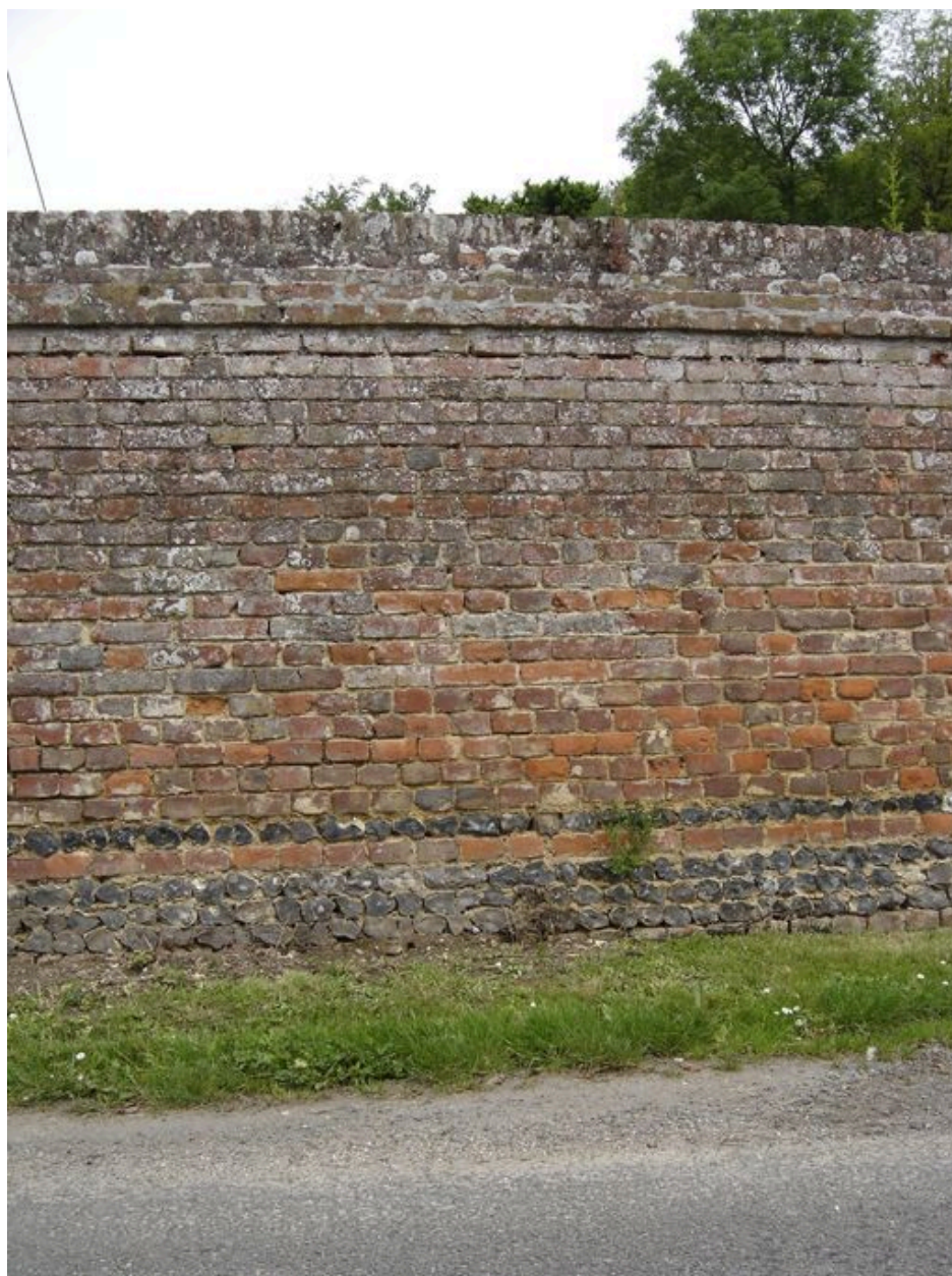
Vue du mur de clôture.
