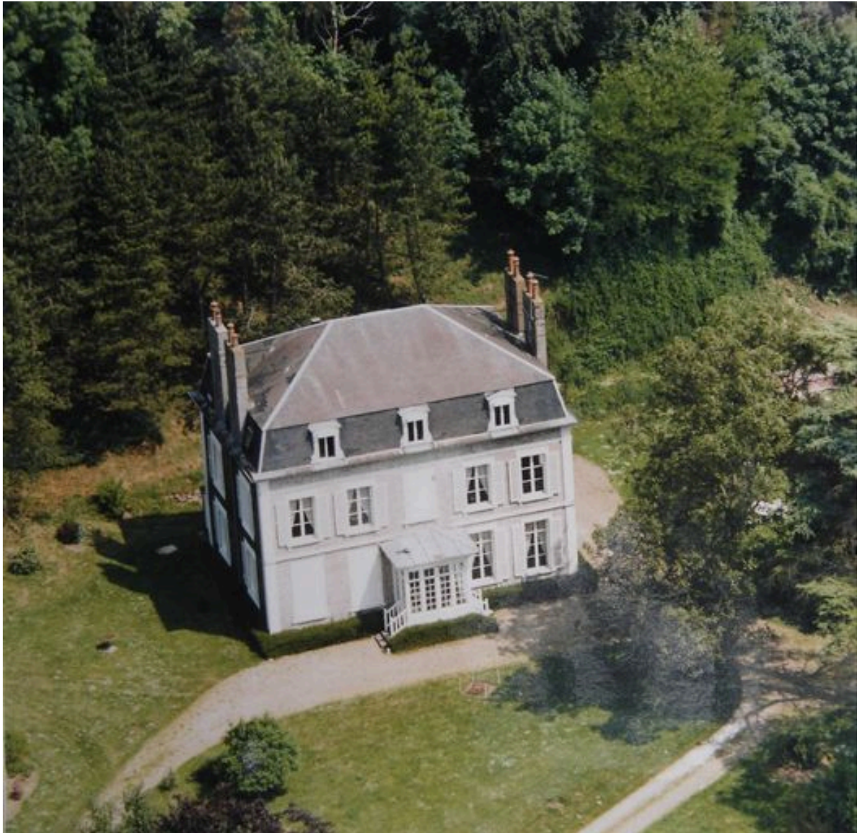
Vue aérienne du château avant l'incendie.
