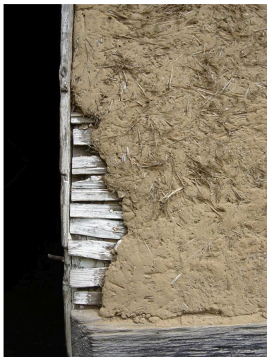
Vue détaillée de la composition du torchis de la grange. Phot. Inès Guérin IVR22_20058005970NUCA
