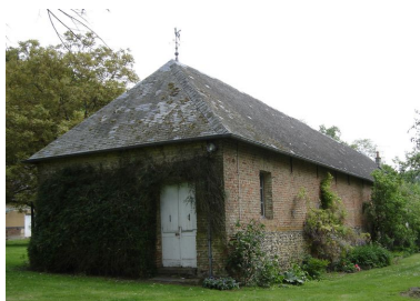
Vue postérieure de ce bâtiment. Phot. Inès Guérin IVR22_20058005974NUCA
