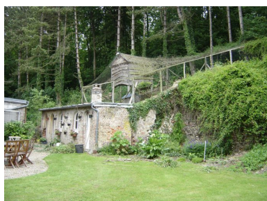
Vue des anciens logements du personnel. Phot. Inès Guérin IVR22_20058005963NUCA
