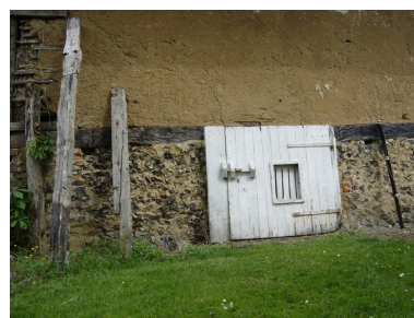
Vue détaillée de la porte de la cave en façade de la grange. Phot. Inès Guérin IVR22_20058005968NUCA
