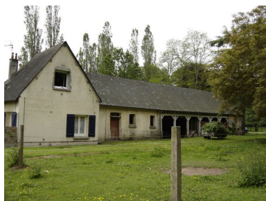
Vue des écuries et du logement du cocher. Phot. Inès Guérin IVR22_20058005973NUCA
