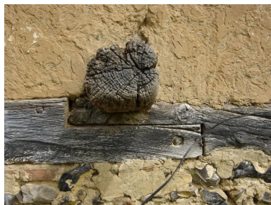
Vue détaillée de la sablière basse de la grange assemblée à mi-bois. Phot. Inès Guérin IVR22_20058005969NUCA
