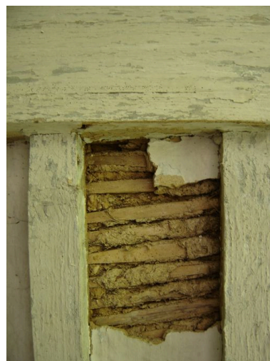
Détail de la composition du plafond des boxes en torchis enroulé autour de lattes placées entre les solives. Phot. Inès Guérin IVR22_20058005979NUCA
