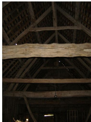
Vue des fermes composant la charpente de la grange. Phot. Inès Guérin IVR22_20058005972NUCA
