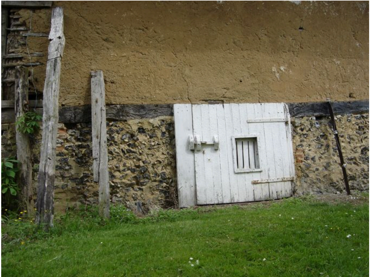
Vue détaillée de la porte de la cave en façade de la grange.
