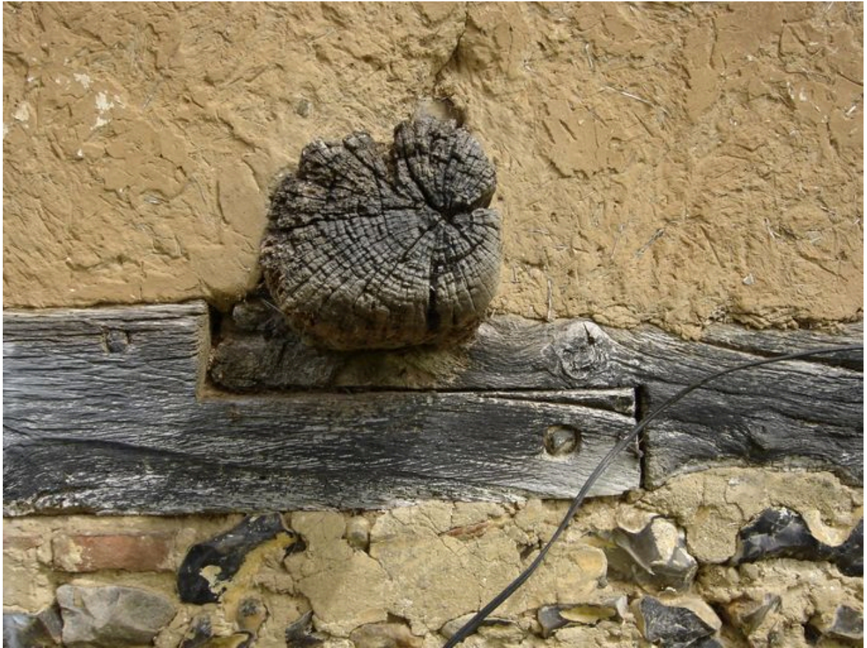
Vue détaillée de la sablière basse de la grange assemblée à mi-bois.
