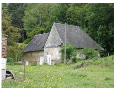
Vue latérale de la grange et des étables depuis la rue. Phot. Inès Guérin IVR22_20058005967NUCA
