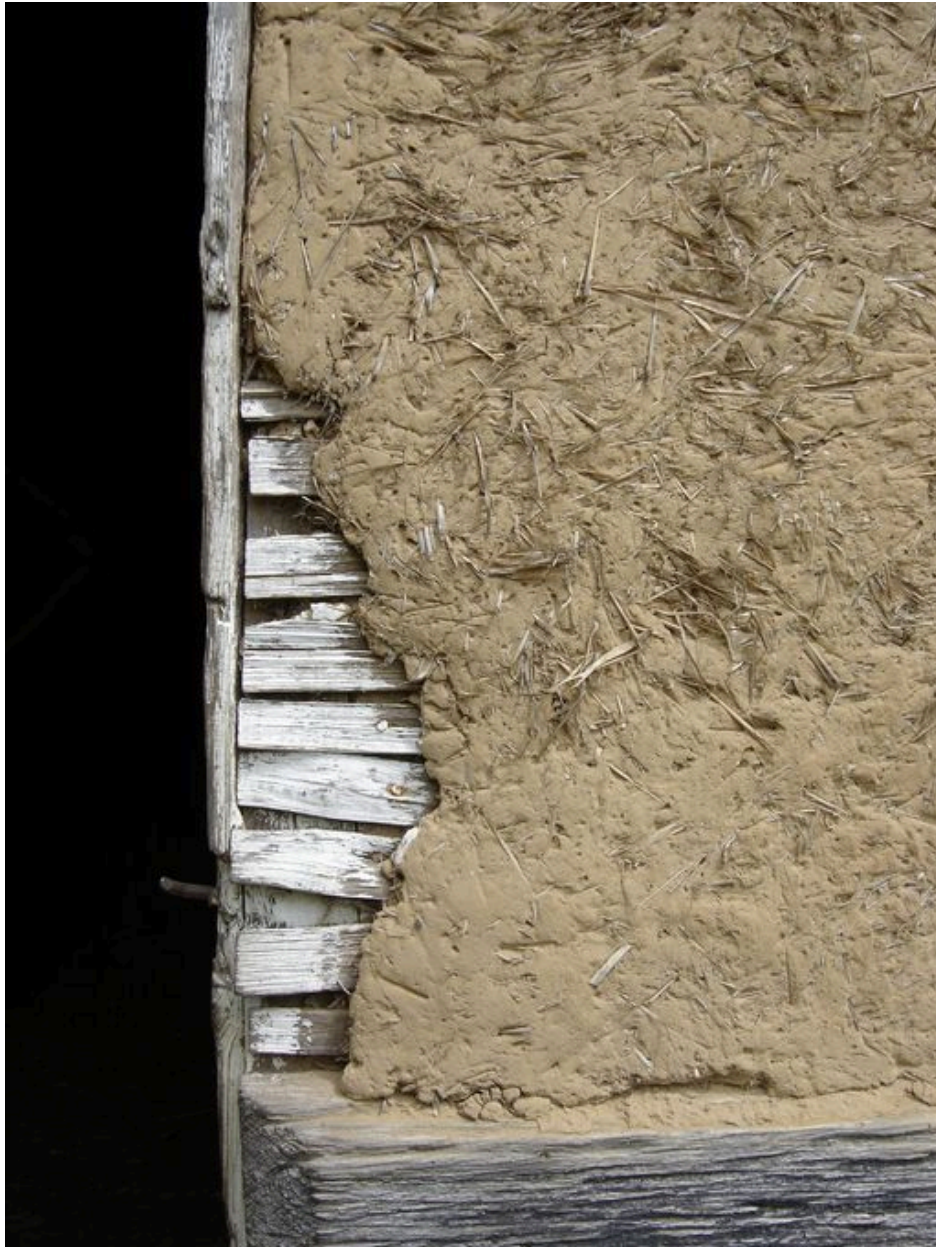
Vue détaillée de la composition du torchis de la grange.
