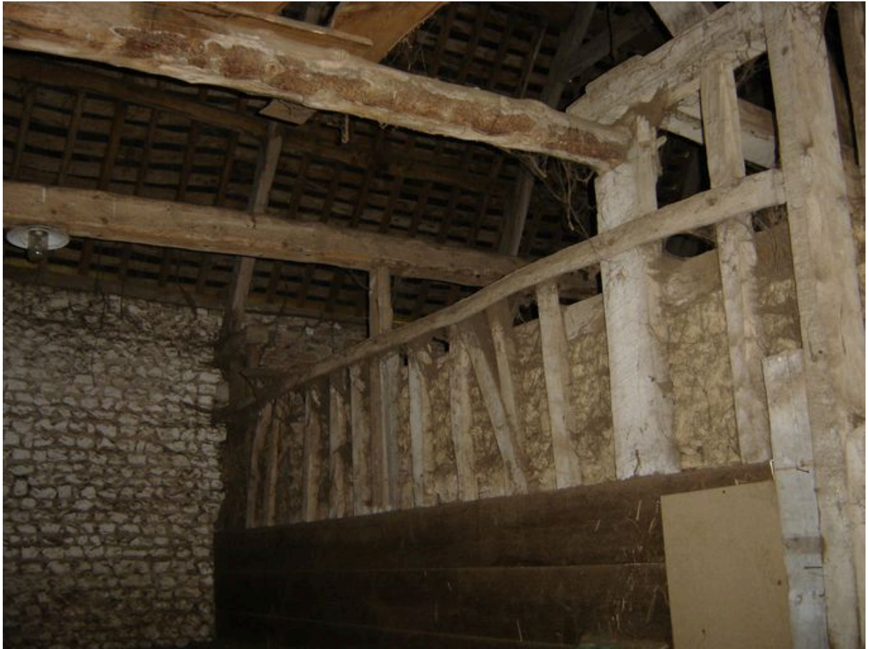
Vue intérieure de la grange.
