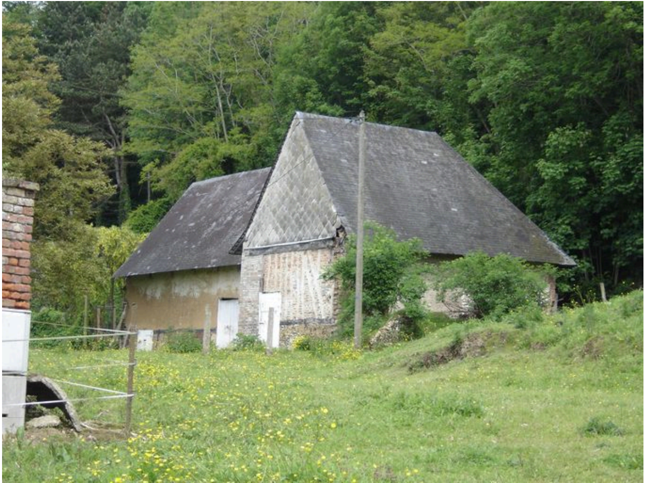
Vue latérale de la grange et des étables depuis la rue.
