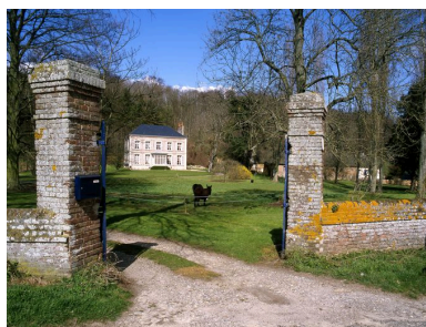
Vue générale. Phot. Marie-Laure Monnehay-Vulliet IVR22_20068000162XA
