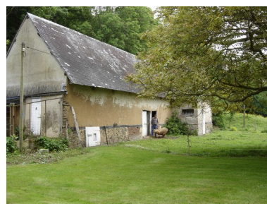
Vue de la grange et des étables depuis le château. Phot. Inès Guérin IVR22_20058005966NUCA
