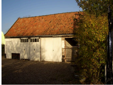
Vue des dépendances. Phot. Inès Guérin IVR22_20068005611NUCA
