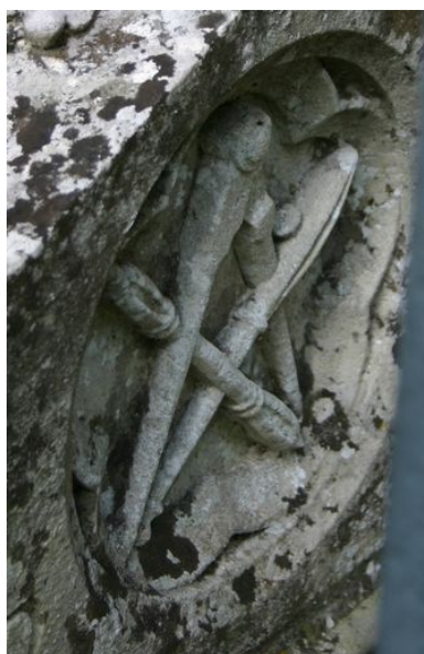
Tombeau d'Aimé Adrien Duthoit. Vue de détail sur le décor sculpté (attributs professionnels de l'architecte). Phot. Caroline Vincent IVR22_20068001471NUCA
