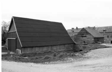
Vue sud-ouest de la grange et de la remise attenante. Phot. Christiane Riboulleau IVR22_19960200440Z
