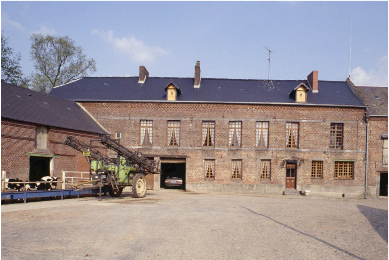
Façade du logis.
