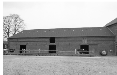
Etable nord : élévation sur cour. Phot. Christiane Riboulleau IVR22_19960200436Z
