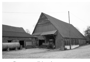
Grange : élévation sur cour. Phot. Christiane Riboulleau IVR22_19960200437Z
