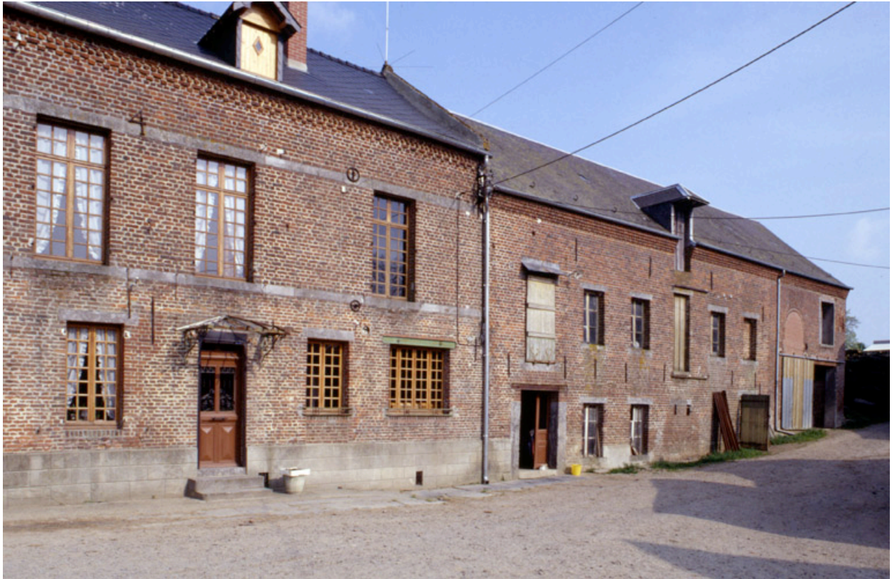
Vue partielle de la façade du logis prolongé par le bâtiment d'eau et les greniers.
