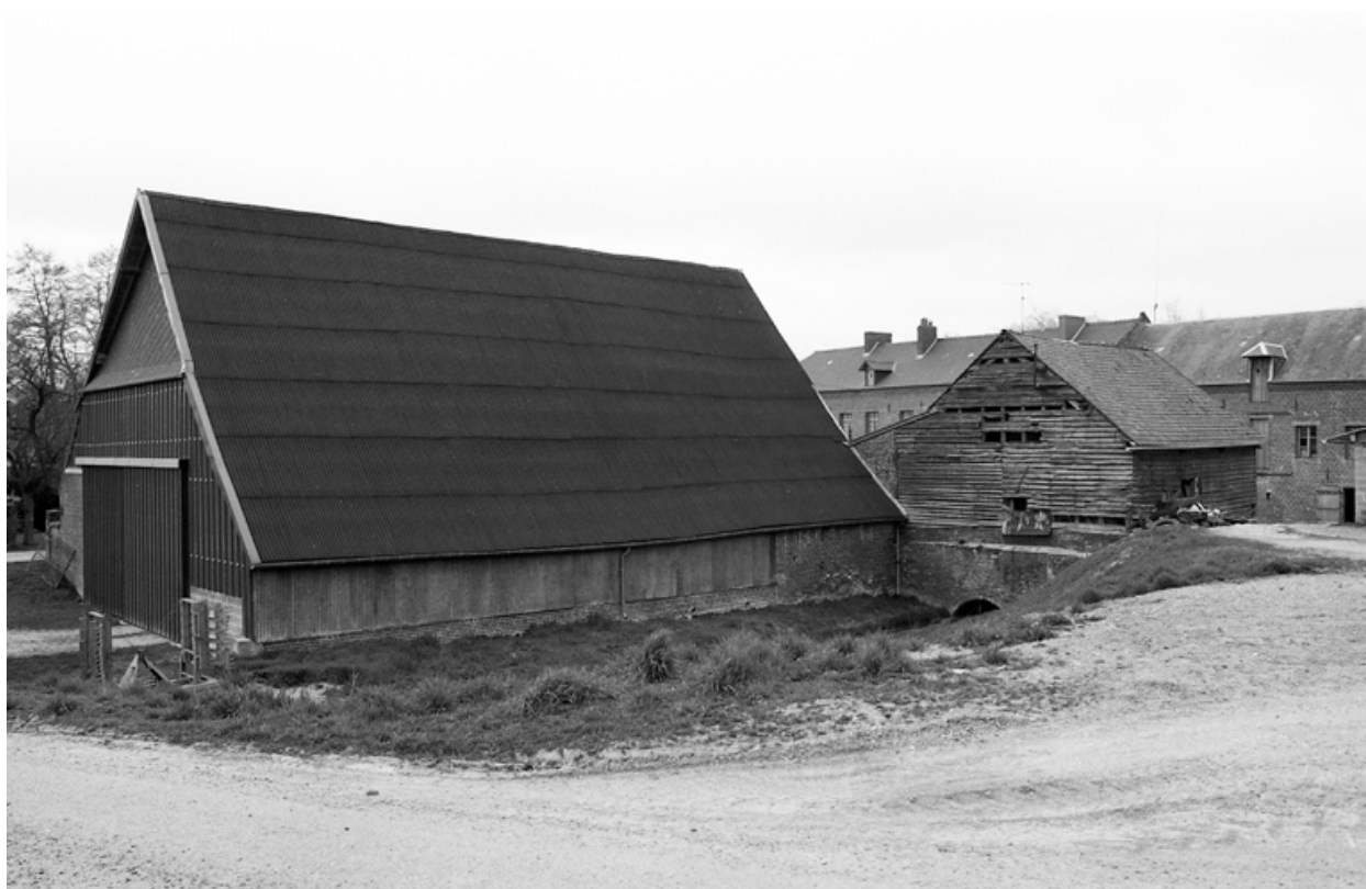
Vue sud-ouest de la grange et de la remise attenante.
