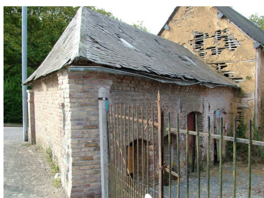
Vue de l'étable. Phot. Frédéric Fournis IVR22_20098005684NUCA
