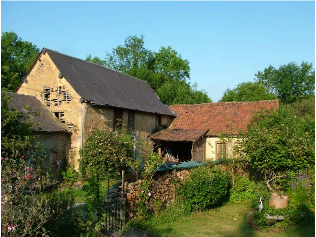
Vue générale des bâtiments d'exploitation.
