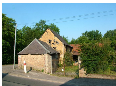
Vue partielle des bâtiments d'exploitation depuis la rue. Phot. Frédéric Fournis IVR22_20108001708NUCA
