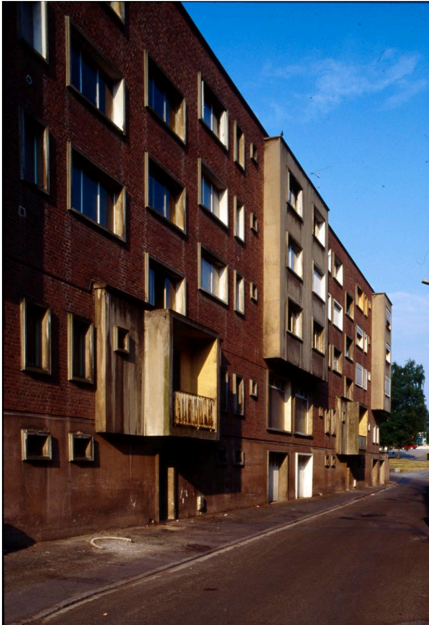
Vue générale de l'élévation postérieure.
