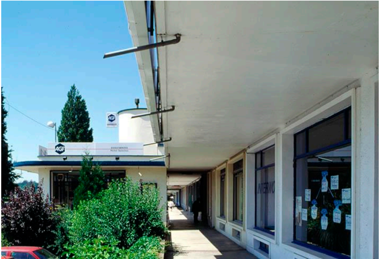
Vue de détail : le portique.
