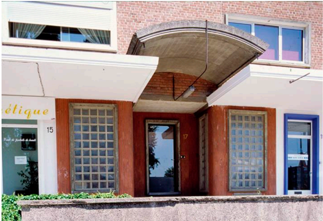
Vue de détail d'une entrée de l'immeuble : l'auvent.
