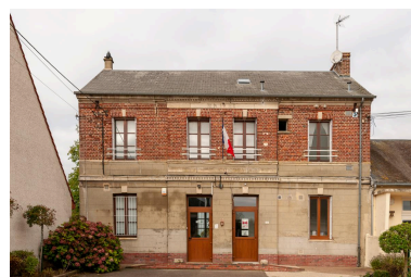
Ancienne mairie-école, aujourd'hui mairie, vue depuis le sud-est. Phot. Marc Kérignard IVR32_20226001134NUCA
