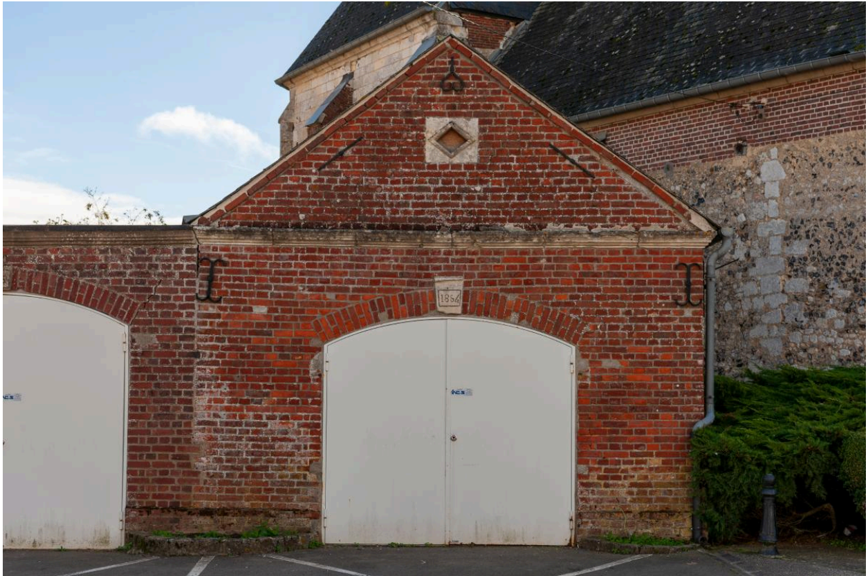
Remise des pompes à incendie, 1864, vue depuis l'ouest.
