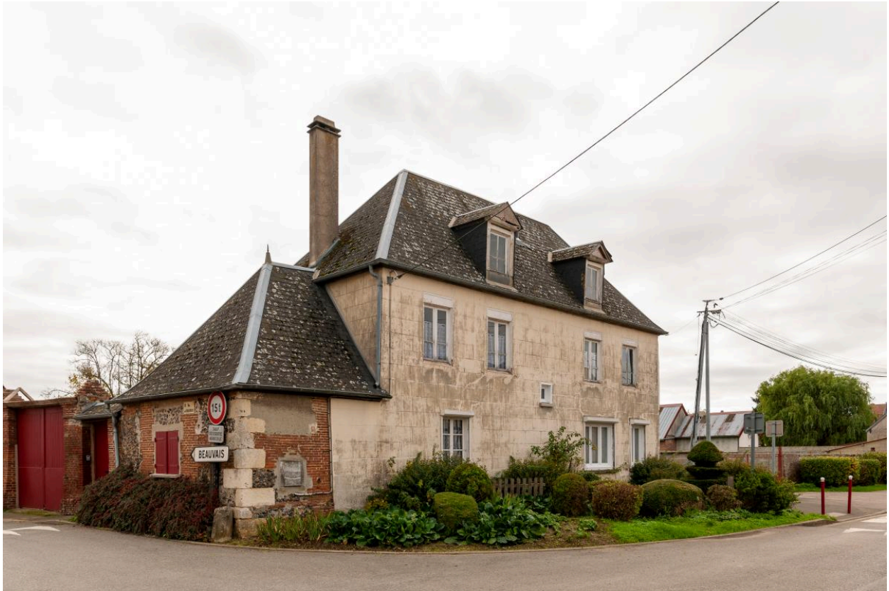
Ancien presbytère, vue depuis le nord.
