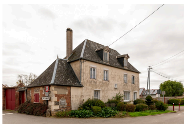
Ancien presbytère, vue depuis le nord. Phot. Marc Kérignard IVR32_20226001133NUCA
