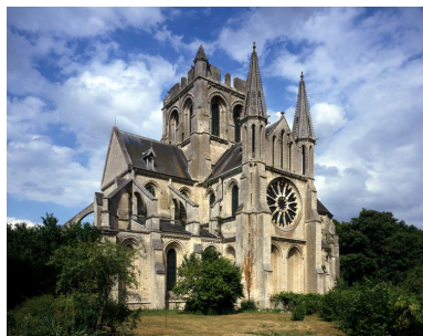
Vue de l'élévation sud. Phot. Irwin Leullier IVR22_20030203313VA
