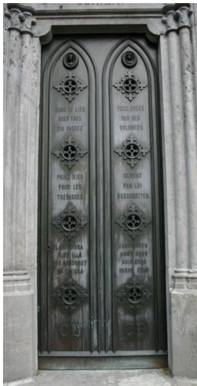
Détail de la porte en fonte. Phot. Caroline Vincent IVR22_20078000784NUCA
