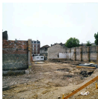
Démolition des bâtiments en 2007. Phot. Thierry Lefébure IVR22_20076000118XA
