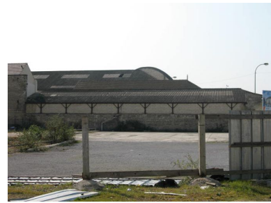
Succession de toitures des entrepôts Boufflette. Phot. Clarisse Lorieux IVR22_20076005176NUCA
