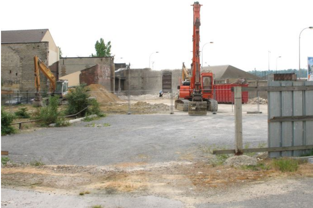
Avril 2007 : état du chantier depuis la rue ds Pierres.
