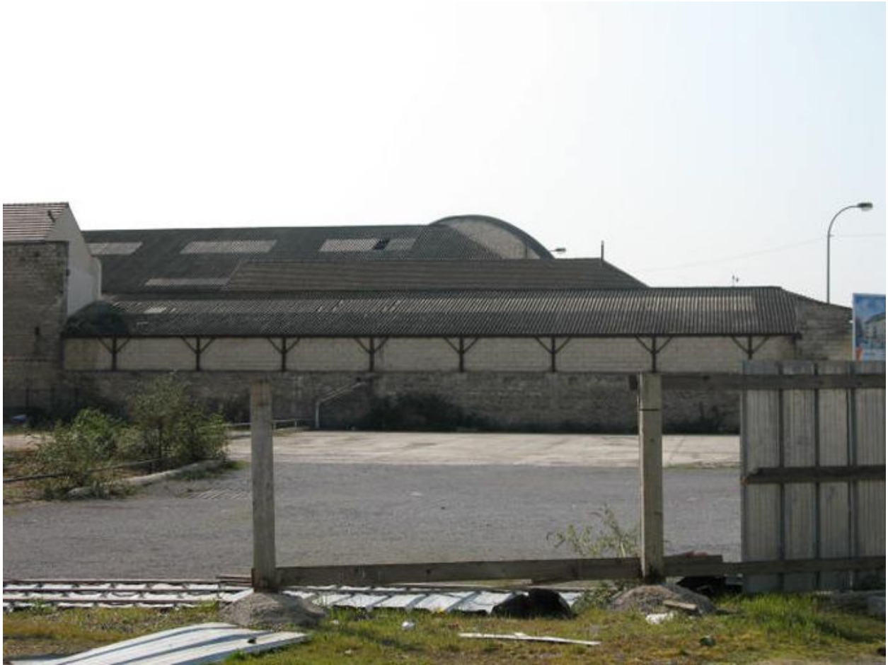
Succession de toitures des entrepôts Boufflette.
