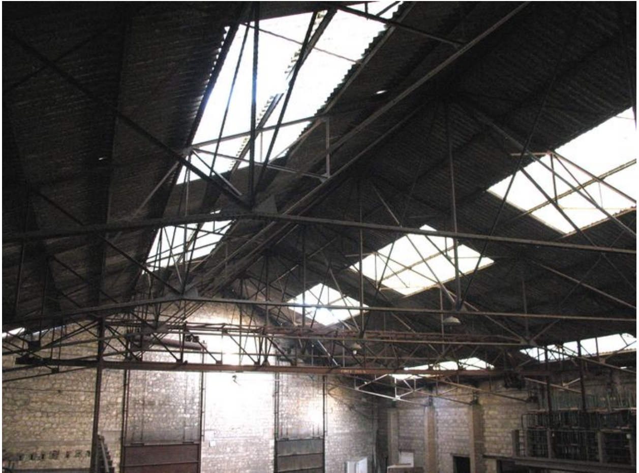
Charpente métallique et toiture de la grande halle.
