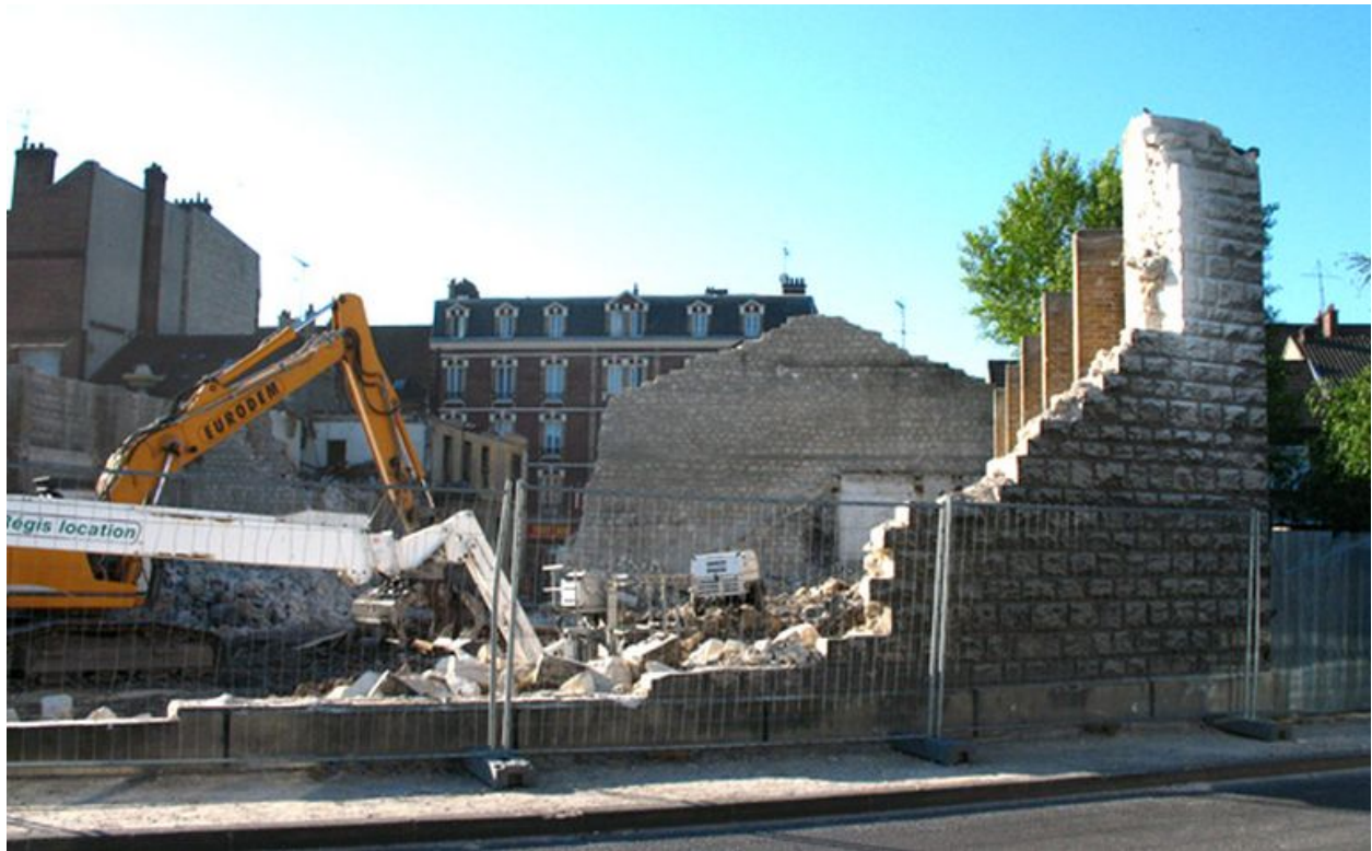
Les entrepôts Boufflette au début du mois de mai 2007.
