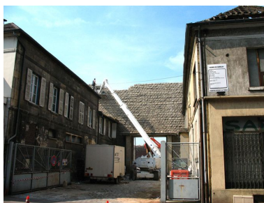
Avril 2007 : démolition de la façade sur la rue Jules Juliet. Phot. Clarisse Lorieux IVR22_20076005207NUCA
