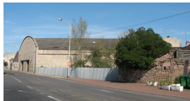
Vue générale des entrepôts depuis la gare. Phot. Clarisse Lorieux IVR22_20076005204NUCA
