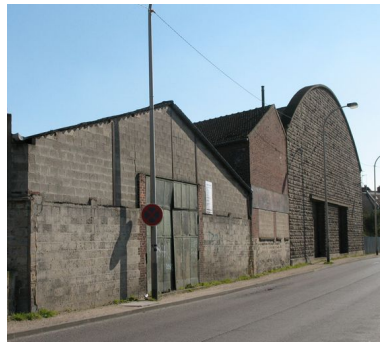
Façades des entrepôts depuis la gare. Phot. Clarisse Lorieux IVR22_20076005174NUCA
