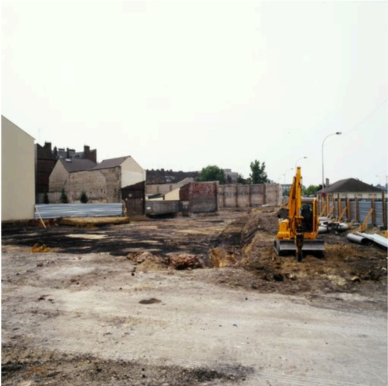
Démolition des anciens entrepôts.
