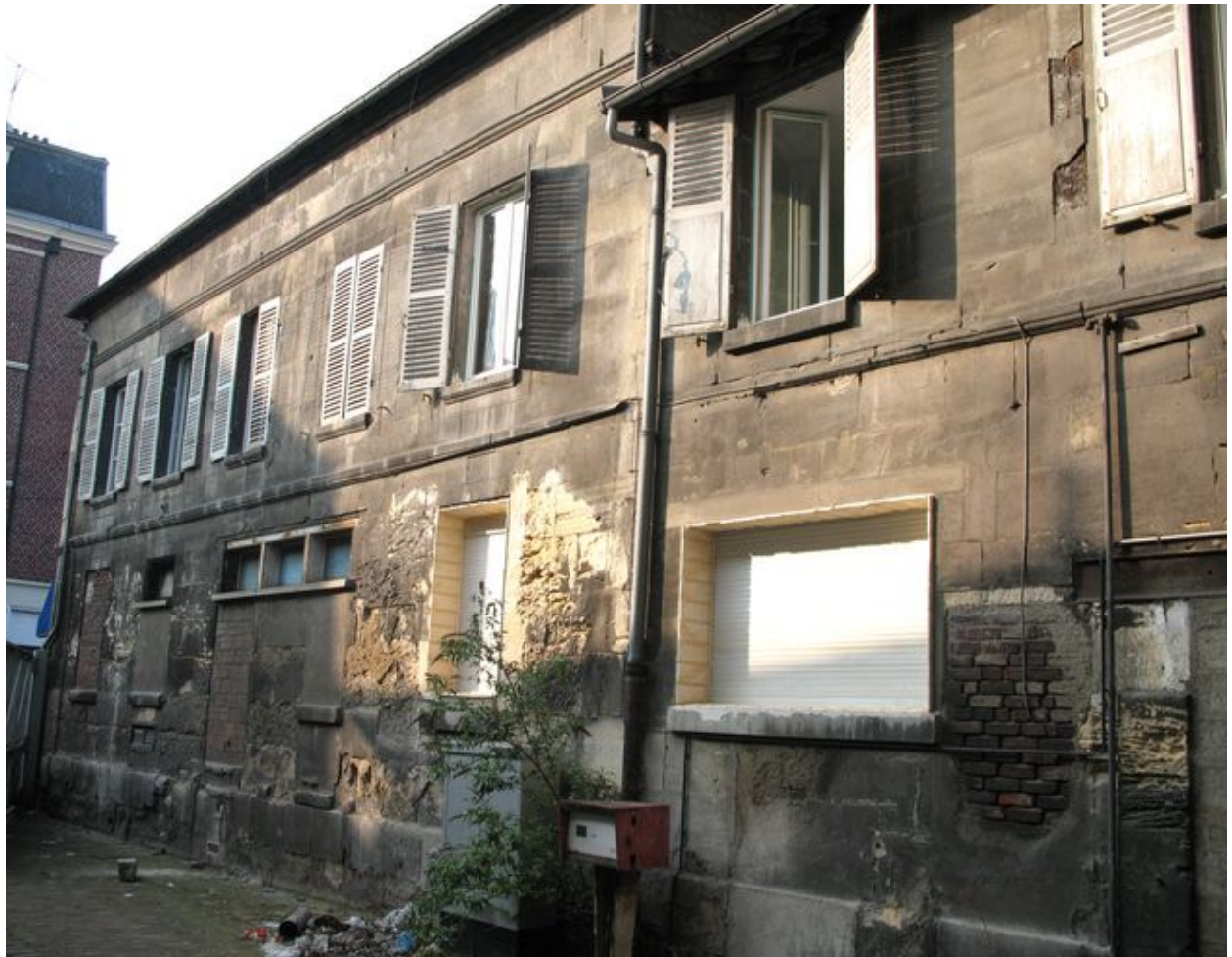
Vue des logements construits face aux bureaux.
