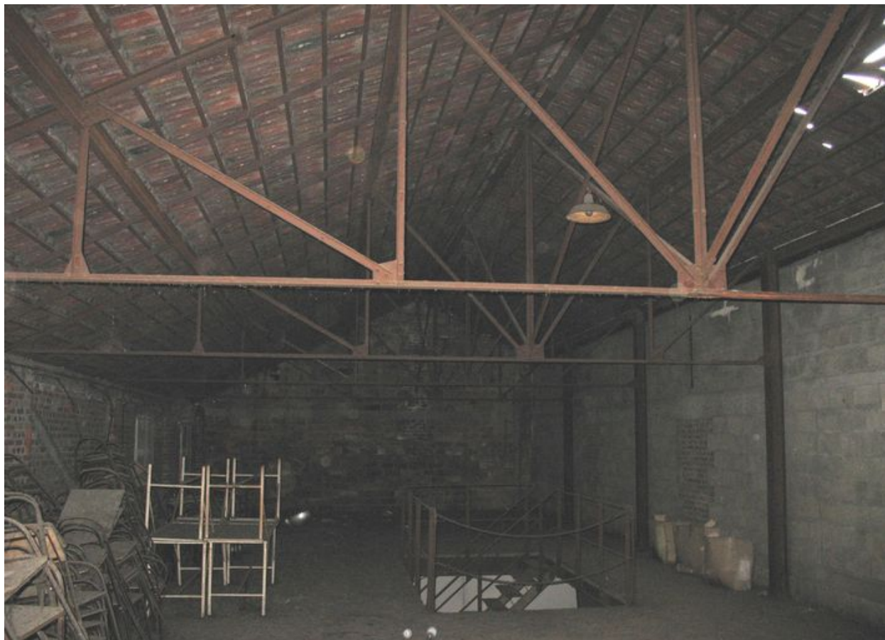
Atelier construit entre les deux halles.
