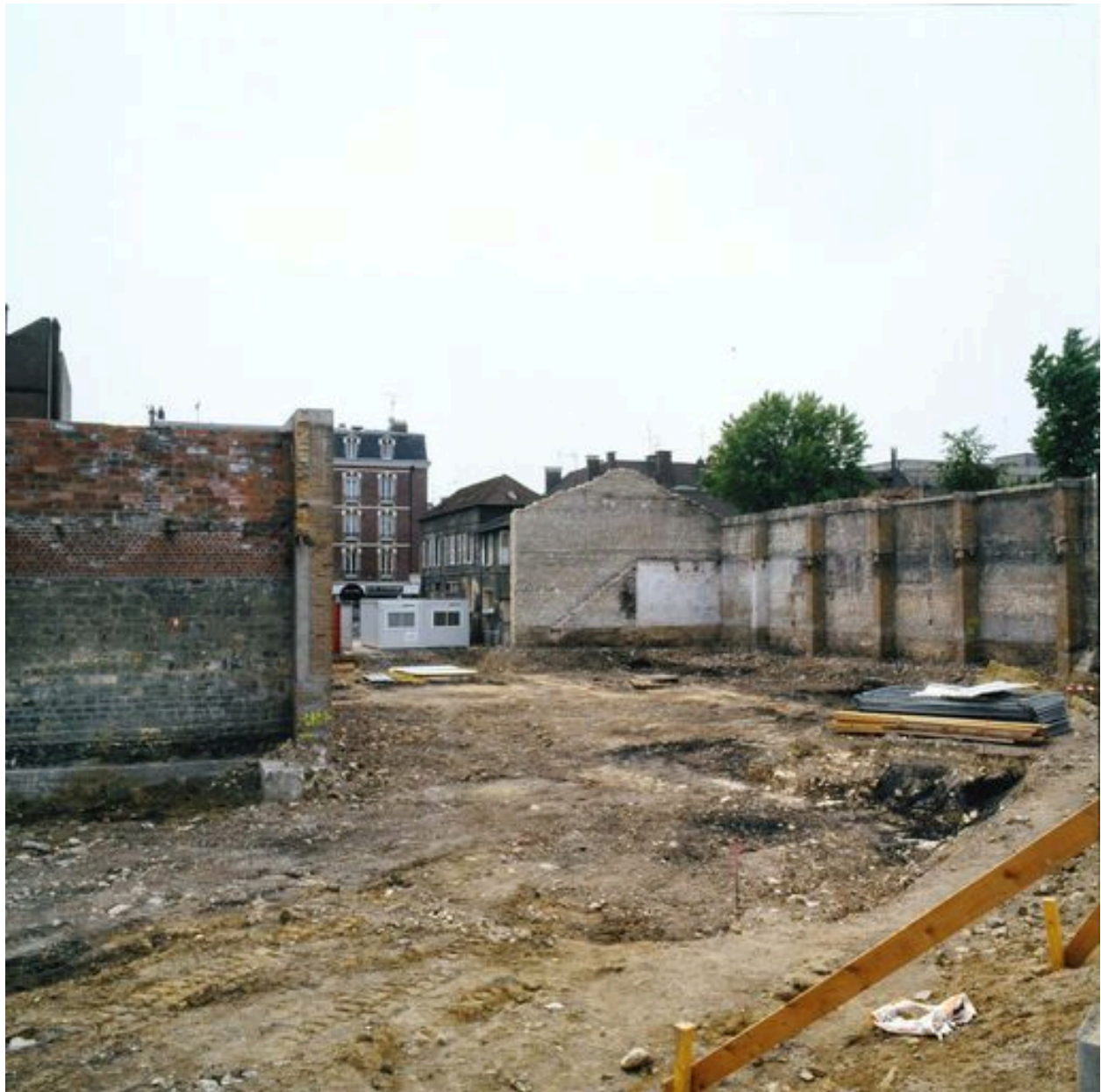
Démolition des bâtiments en 2007.
