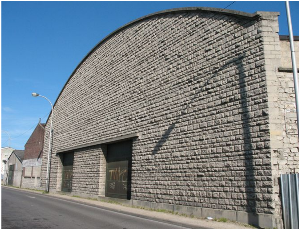
Entrepôt principal construit en pierre de Saint-Maximin.
