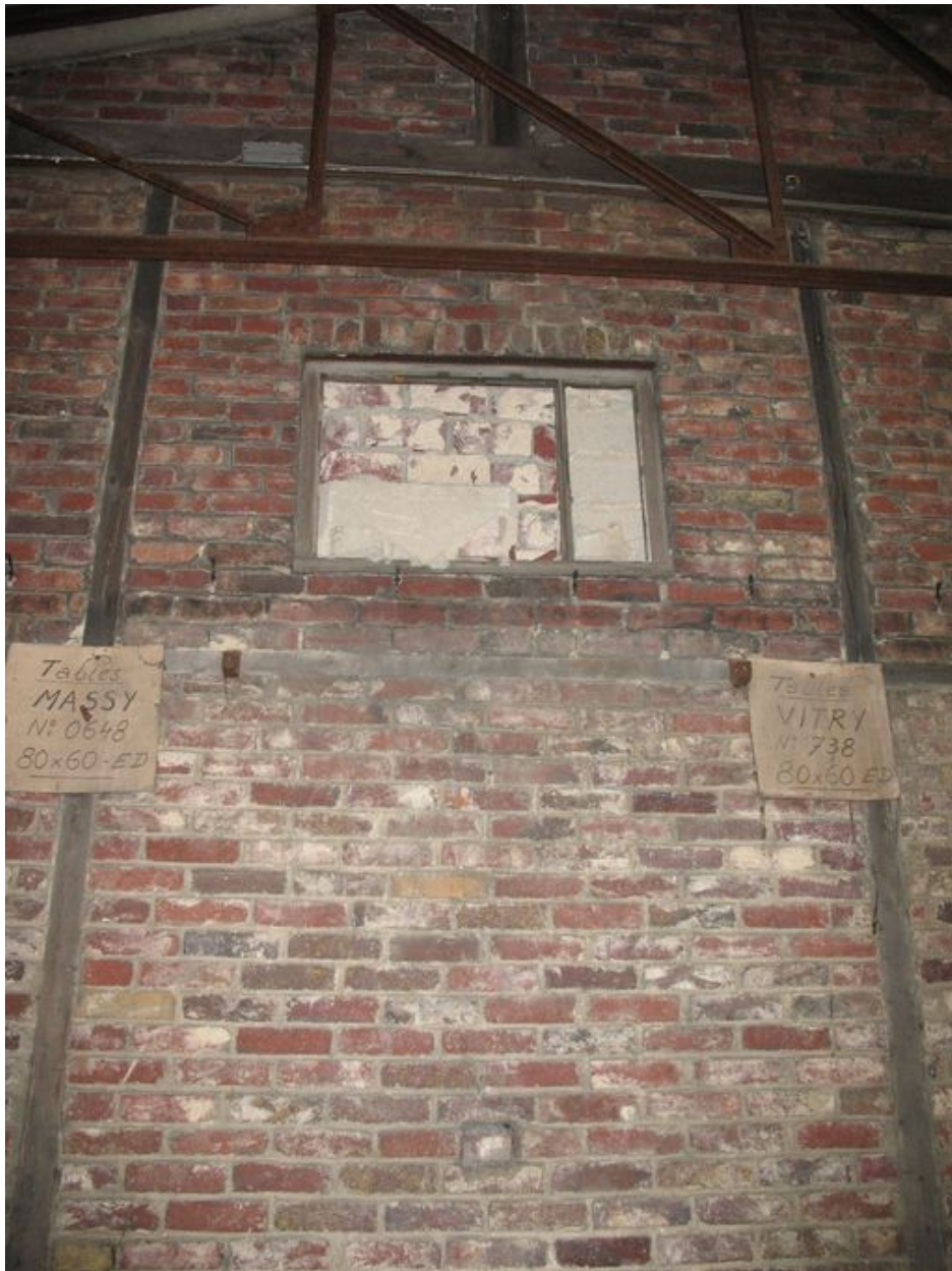
Mur sud de la petite halle.
