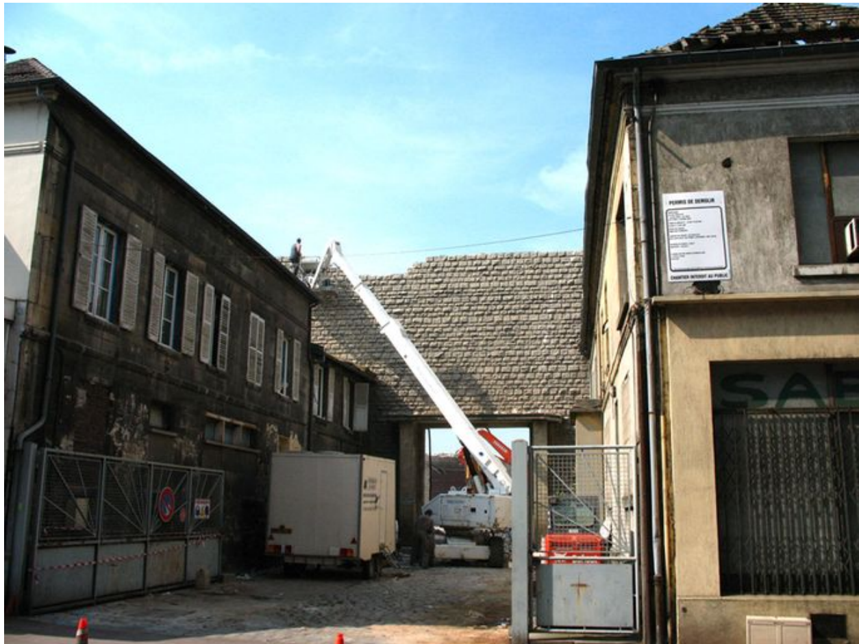
Avril 2007 : démolition de la façade sur la rue Jules Juillet.
