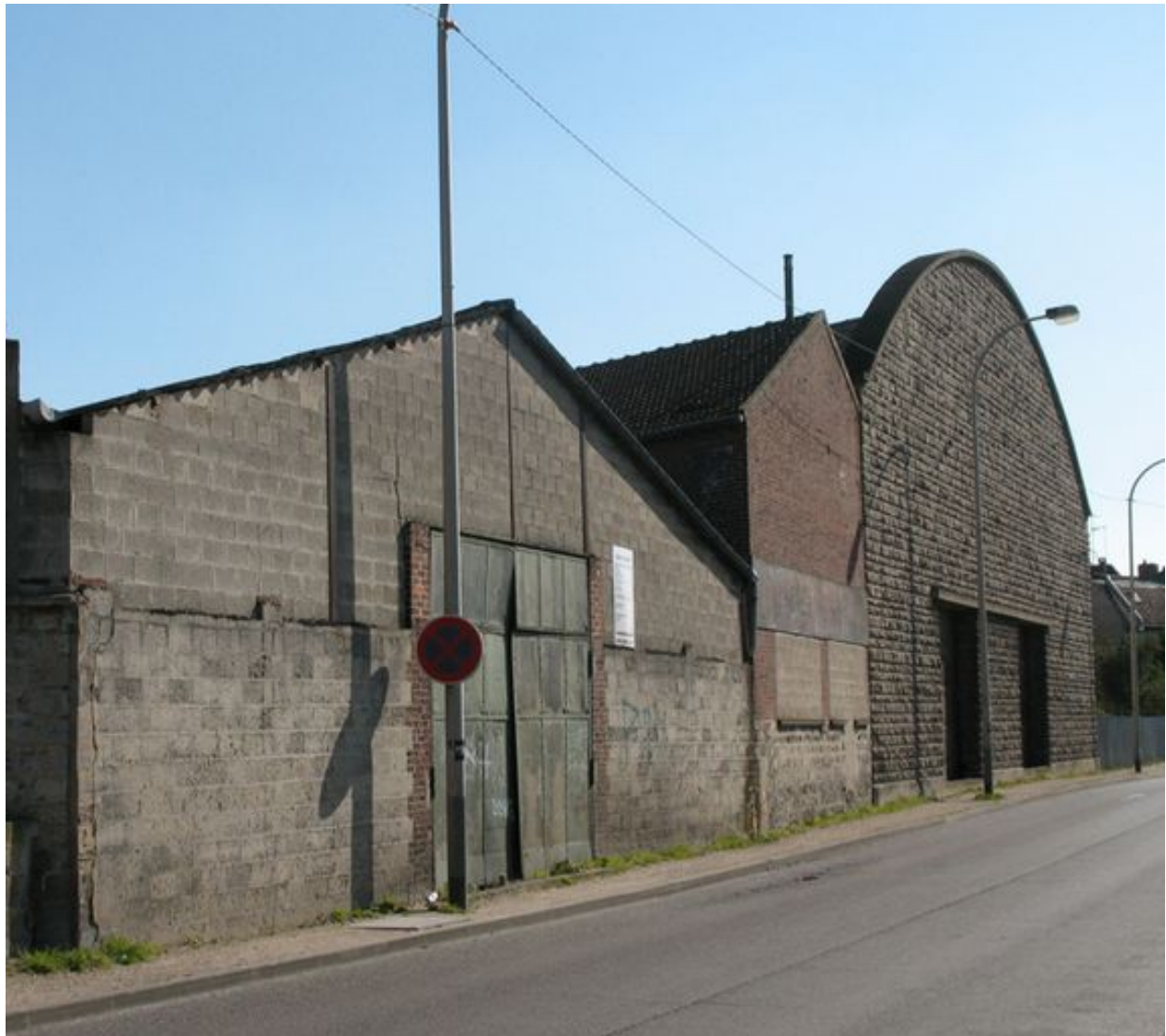
Façades des entrepôts depuis la gare.
