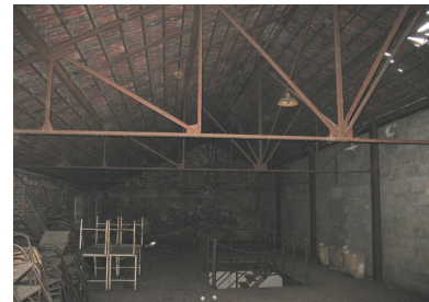
Atelier construit entre les deux halles. Phot. Clarisse Lorieux IVR22_20076005171NUCA
