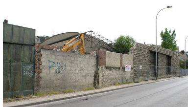
Avril 2007 : façades sur la rue Stéphenson. Phot. Clarisse Lorieux IVR22_20076005209NUCA
