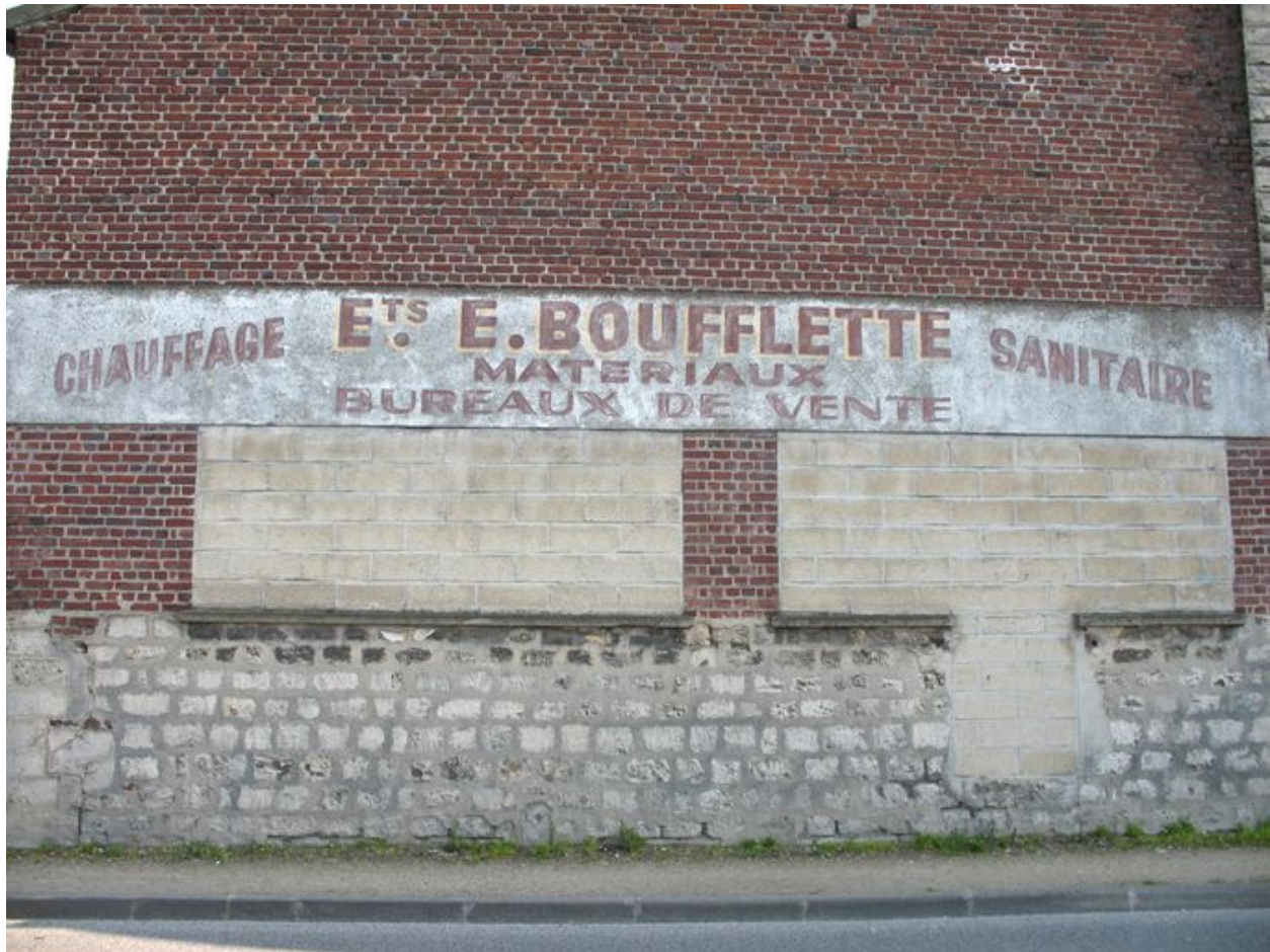
Entrée des entrepôts face à la gare.
