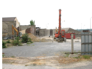
Avril 2007 : état du chantier depuis la rue ds Pierres. Phot. Clarisse Lorieux IVR22_20076005208NUCA
