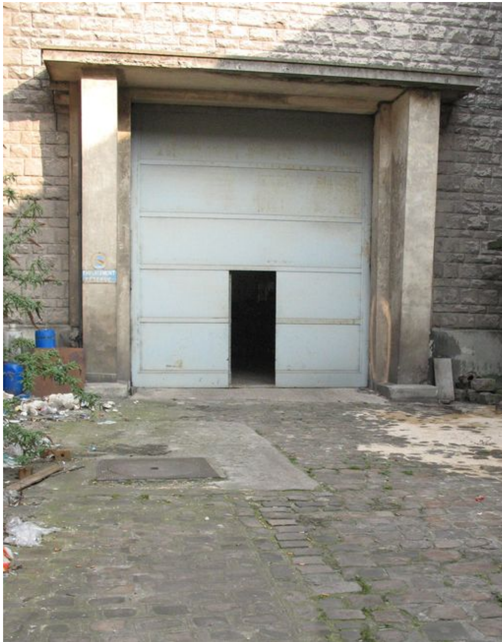
Porte d'entrée des entrepôts Boufflette.
