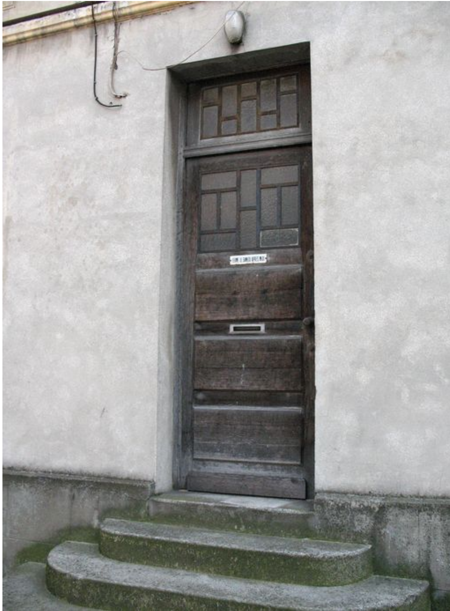
Porte d'entrée des bureaux.
