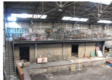
Quai de transbordement de la grande halle. Phot. Clarisse Lorieux IVR22_20076005162NUCA
