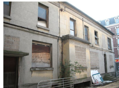
Les bureaux encadrant l'entrée des entrepôts. Phot. Clarisse Lorieux IVR22_20076005158NUCA
