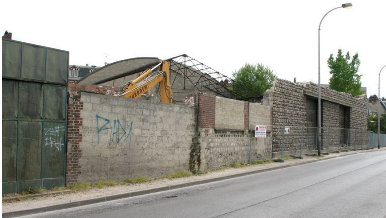
Avril 2007 : façades sur la rue Stéphenson.
