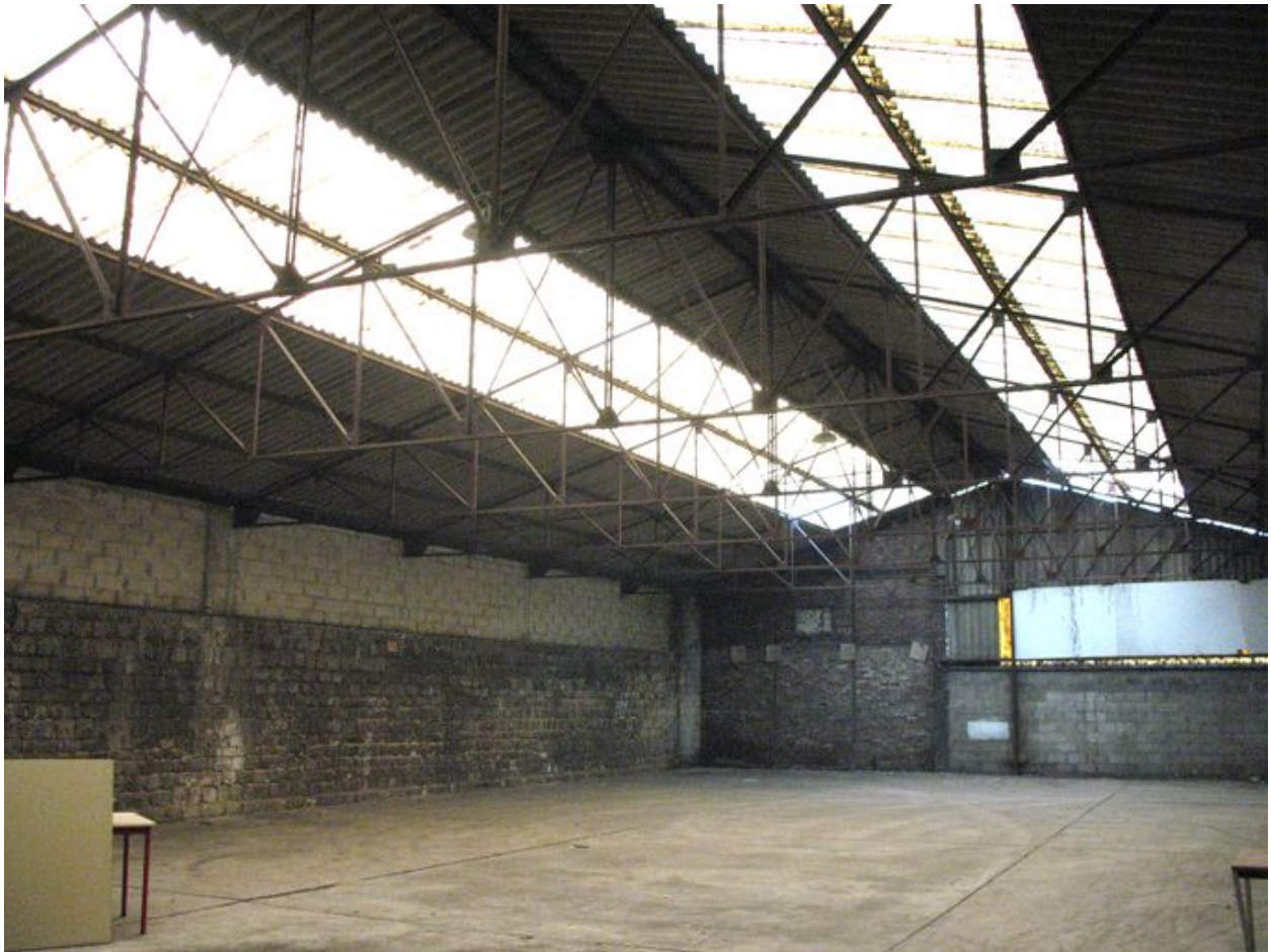
Vue générale de la petite halle et de sa charpente.
