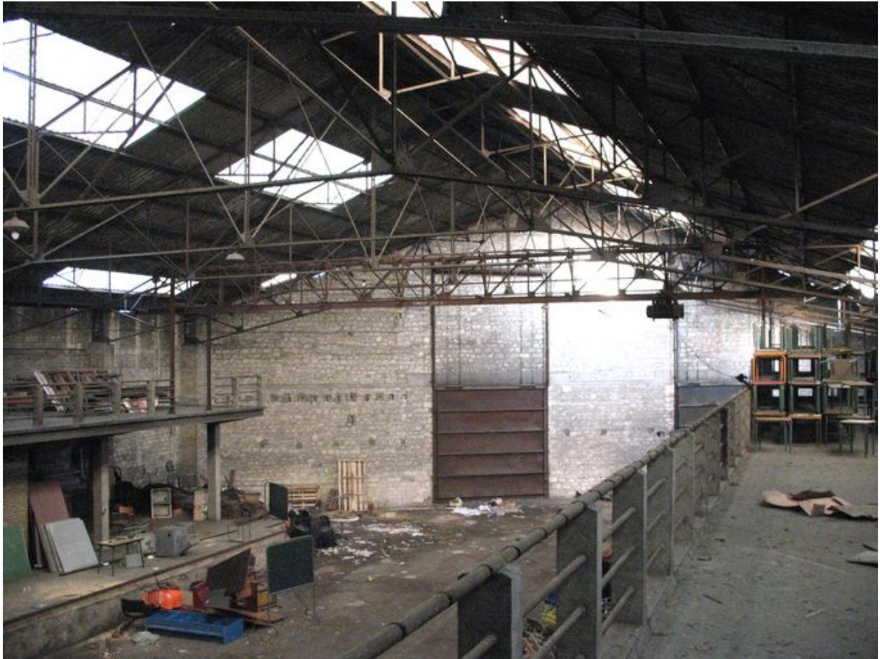
La grande halle depuis la mezzanine.
