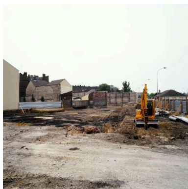
Démolition des anciens entrepôts. Phot. Thierry Lefébure IVR22_20076000119XA
