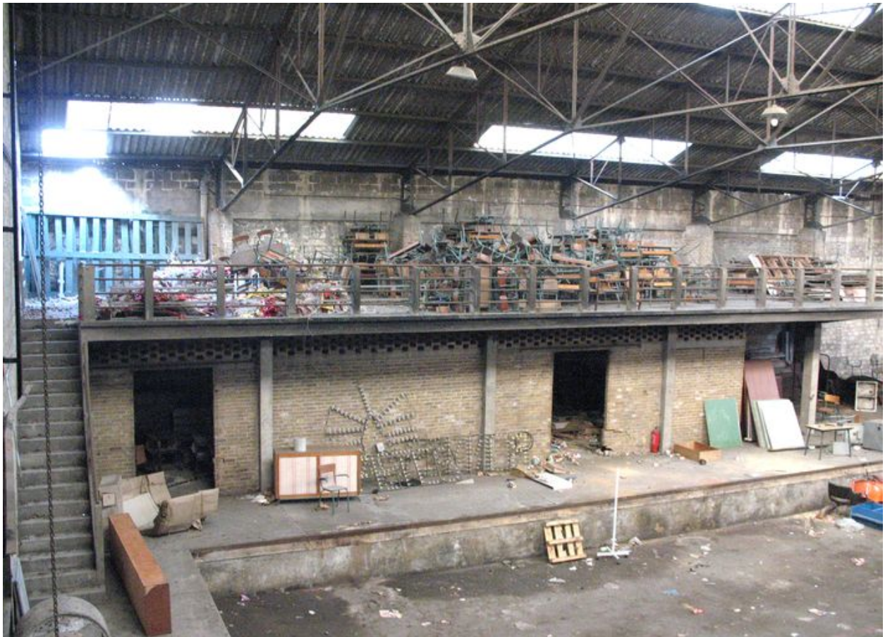
Quai de transbordement de la grande halle.
