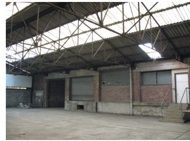
Zone de transbordement de la petite halle. Phot. Clarisse Lorieux IVR22_20076005168NUCA
