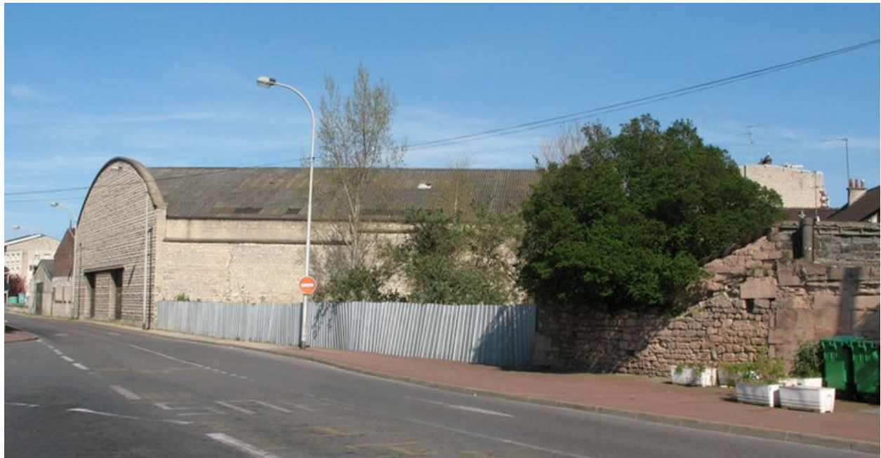
Vue générale des entrepôts depuis la gare.
