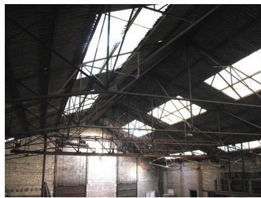
Charpente métallique et toiture de la grande halle. Phot. Clarisse Lorieux IVR22_20076005164NUCA
