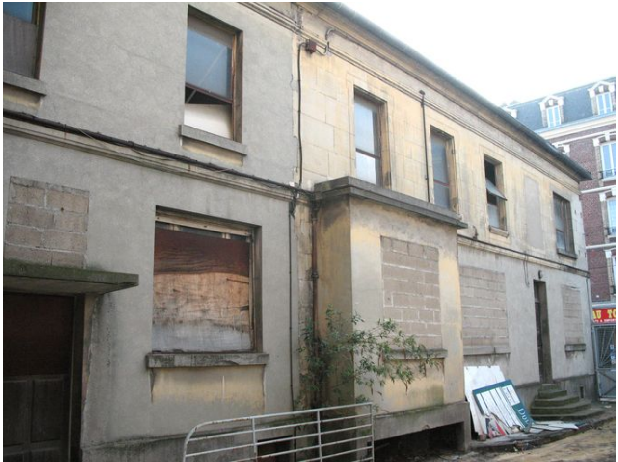
Les bureaux encadrant l'entrée des entrepôts.
