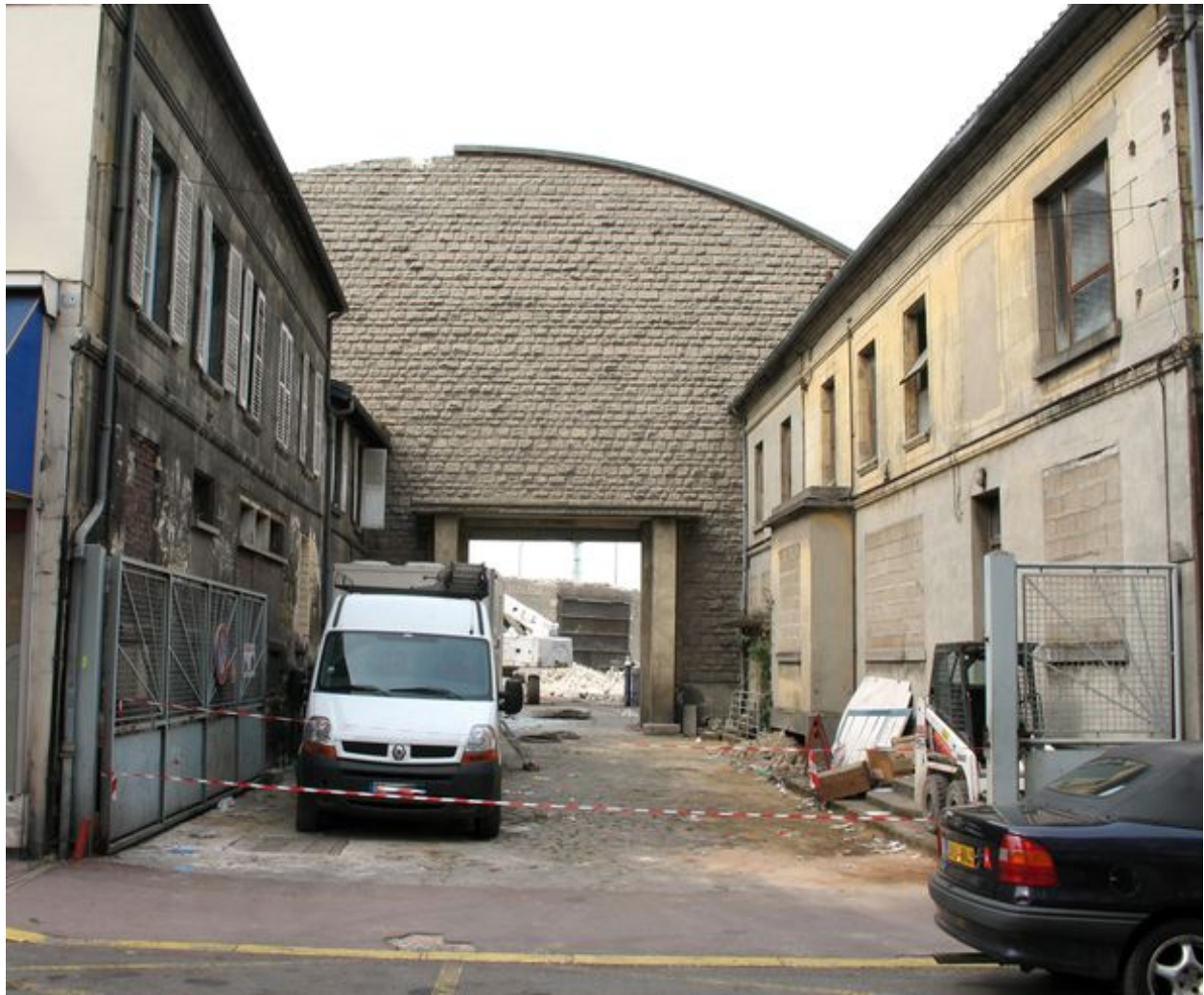
Avril 2007 : début de la démolition de la façade rue Jules Juillet.
