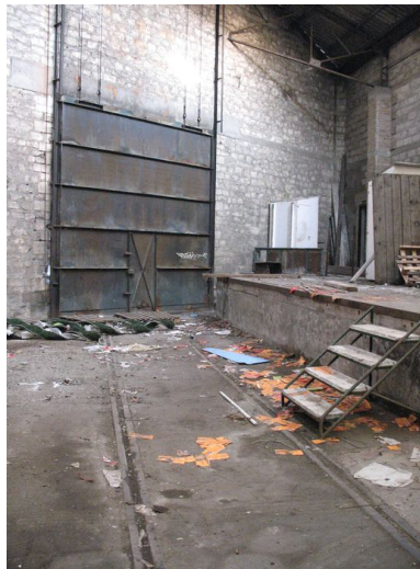
Raccordement ferroviaire des entrepôts. Phot. Clarisse Lorieux IVR22_20076005166NUCA
