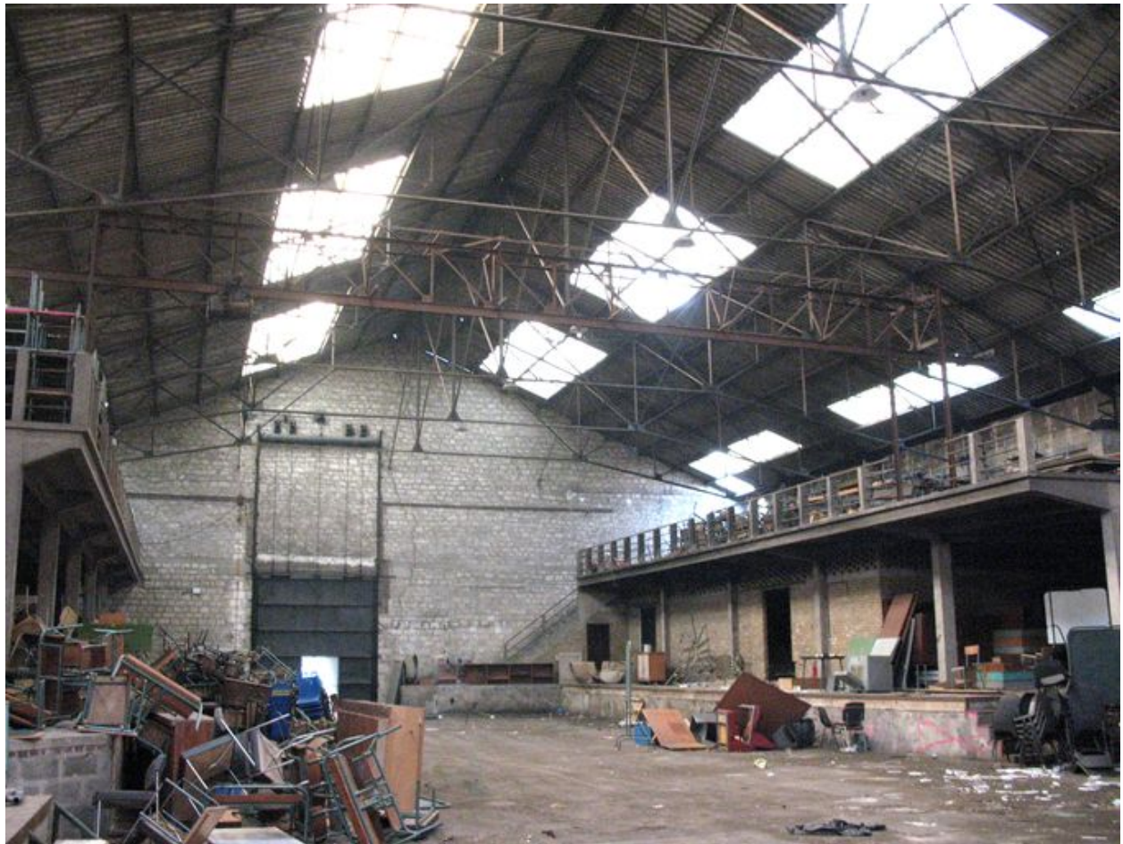
Vue intérieure de la halle principale.
