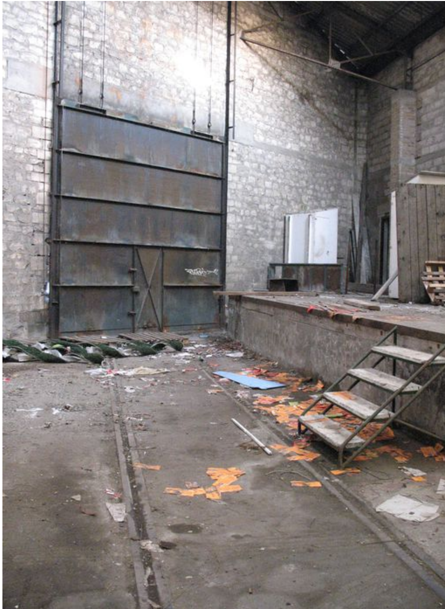
Raccordement ferroviaire des entrepôts.
