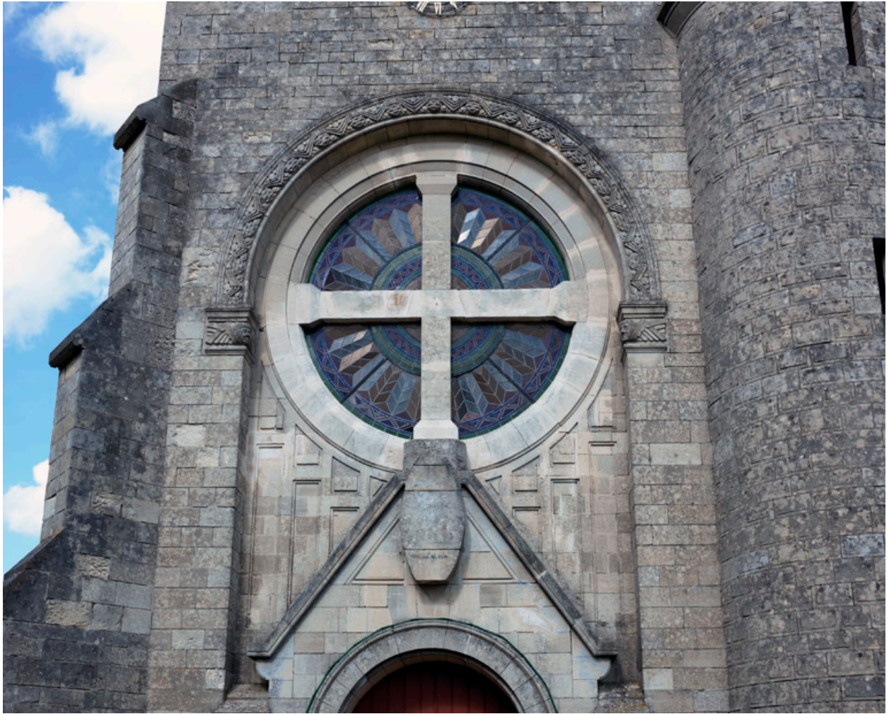
Vue de détail de la façade principale.
