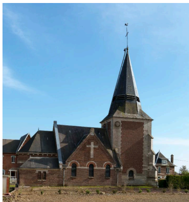
Vue générale depuis le nord. Phot. Marie-Laure Monnehay-Vulliet IVR22_20148000365NUC2A
