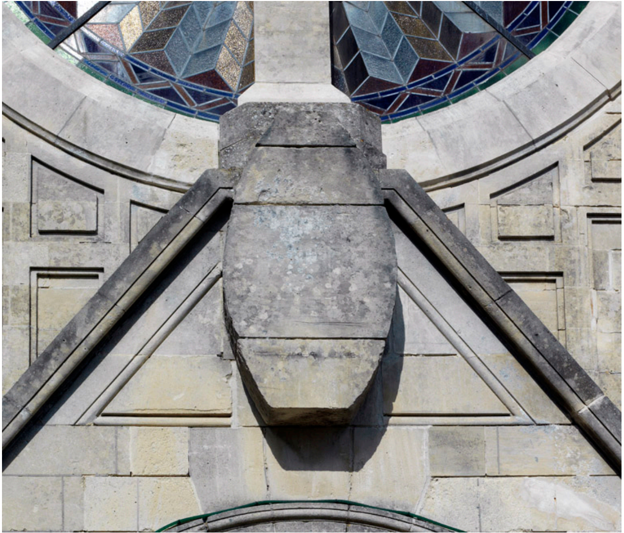
Vue de détail sur la façade principale : clef en attente d'un décor non réalisé.
