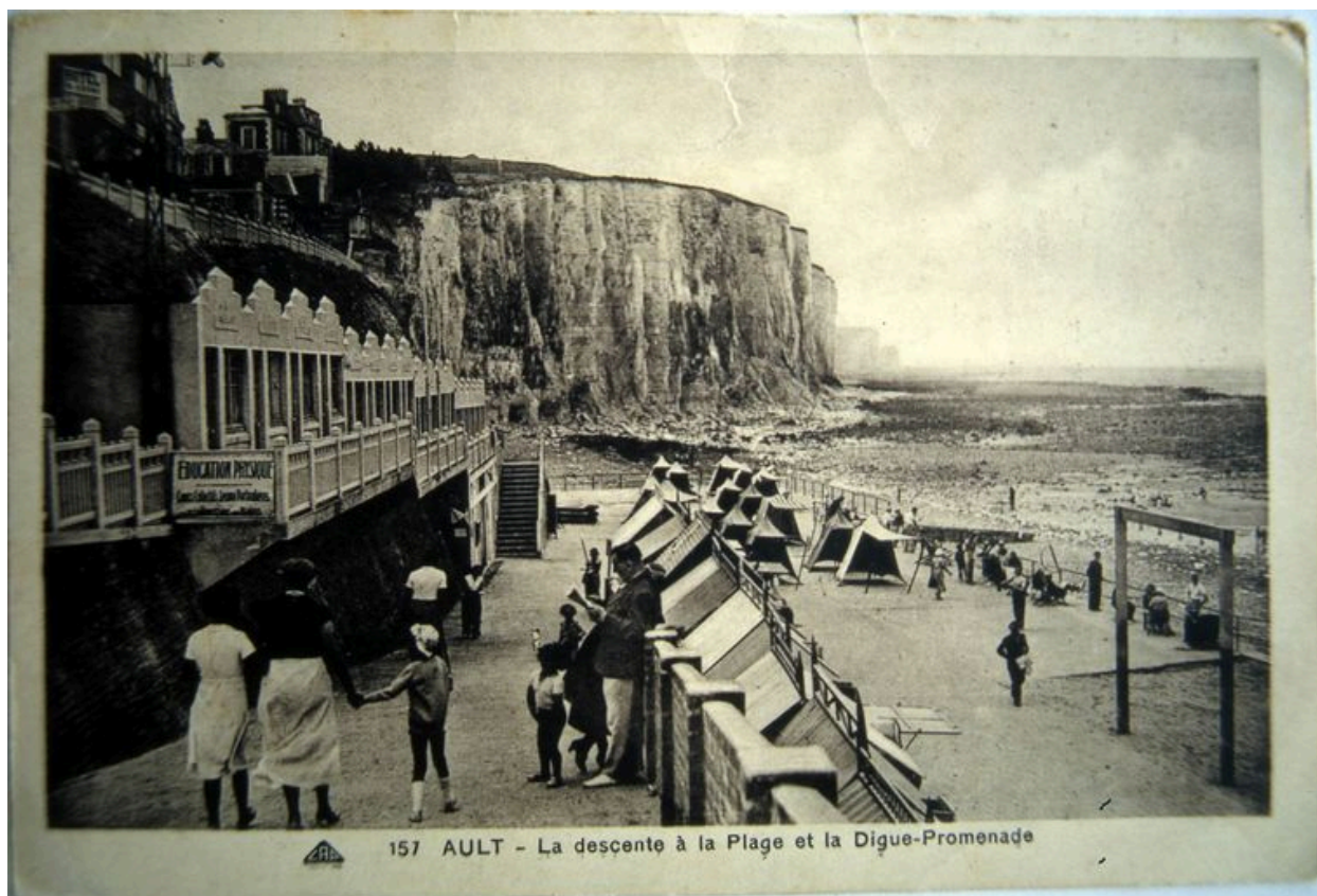
Les anciennes cabines en maçonnerie du Bourg-d'Ault, construites en 1929 (disparues).
