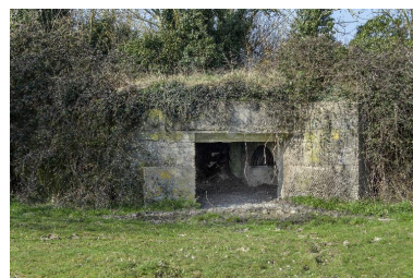
Elévation sud, entrée du canon Phot. Jean-Marc Ramette IVR32_20165901000NUCA
