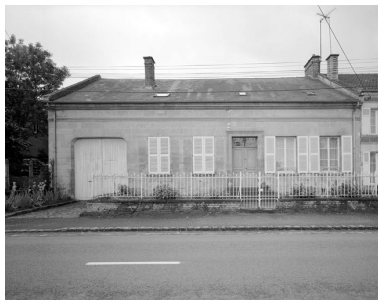
Elévation antérieure. Phot. Jean-Michel Perrin IVR22_19856000804V
