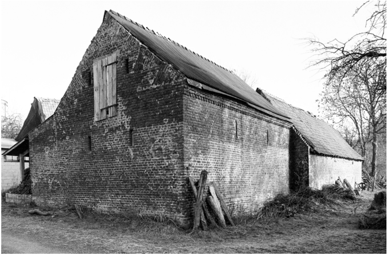
Elévation extérieure des étables depuis le sud.
