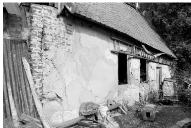
Vue actuelle de la façade du logis en torchis. Phot. Christiane Riboulleau IVR22_19940201463Z
