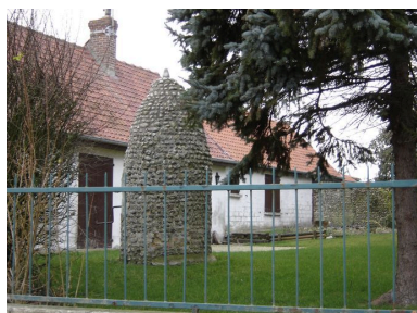
Vue détaillée du puits. Phot. Catherine Fourmond IVR22_20058001438NUCA
