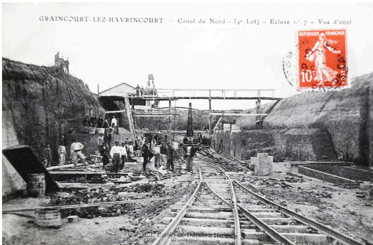
Chantier de l'écluse : réseau ferré technique en fond de fouille et observation de la base des bajoyers en cours de construction, carte postale, entre 1908 et 1914 (collection particulière.)
