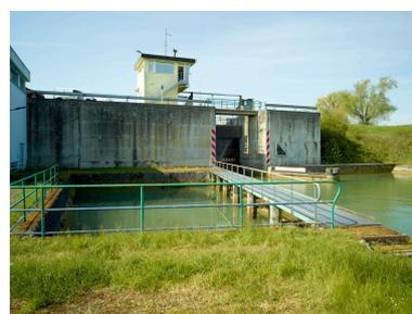
Vue en aval du site. Bassin de tranquillisation, passerelle, poste de commande, porte levante.
