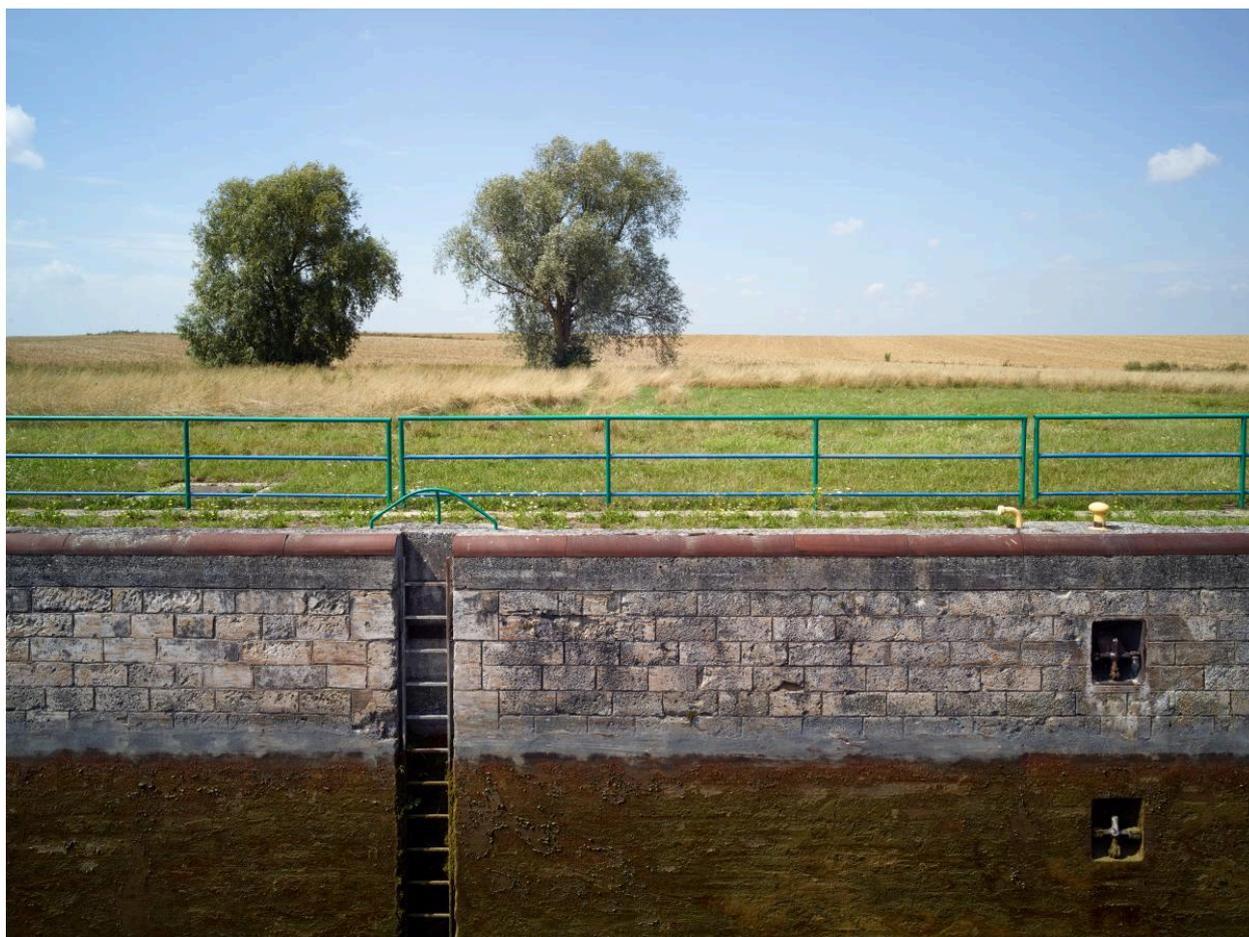
Détail de l'écluse du bajoyer. Échelle et double système d'amarrage en croix.
