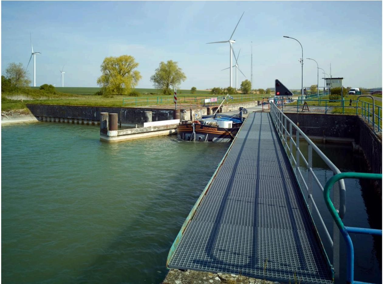
Vue de la tête amont avec estacade de guidage (passerelle et potteau d'amarrage (type Duc d'Albe)).
