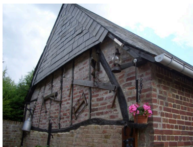
Vue d'une ferme des écuries utilisée en remploi. Phot. Inès Guérin IVR22_20068005152NUCA
