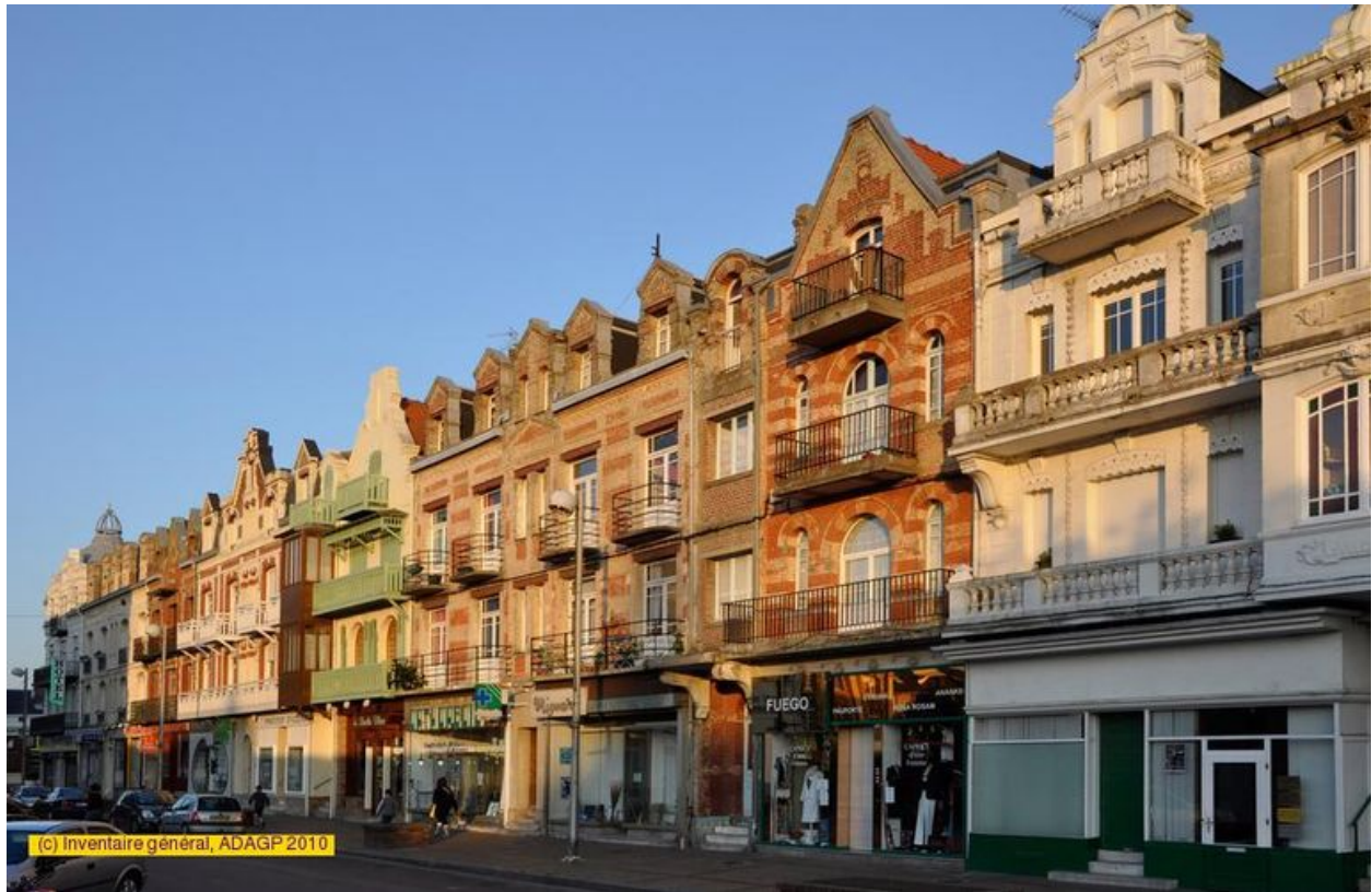
Vue générale de l'immeuble de l'avenue du Général-de-Gaulle.
