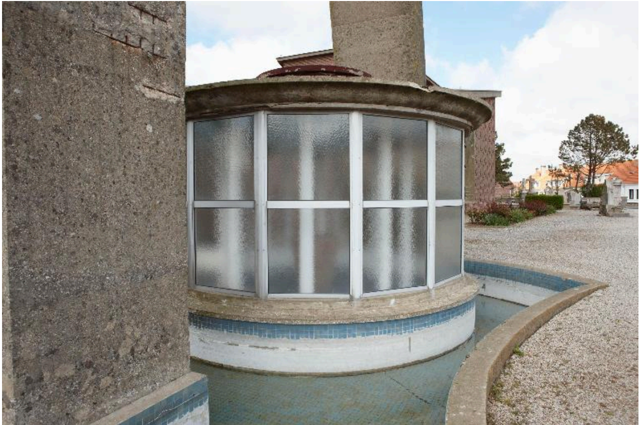
Balcons rue de la Mer ; Henri Valette et Gaston Bellêtre architectes.
