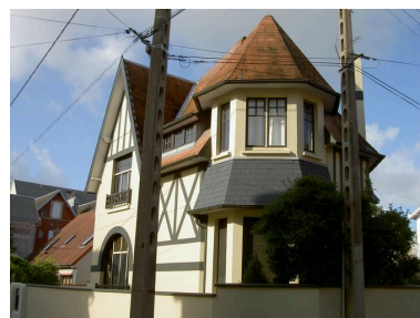
Villa, 2 rue des Ondines, construite par Chiossone et Michel architectes. Phot. Sophie Luchier IVR31_20116201521NUCA
