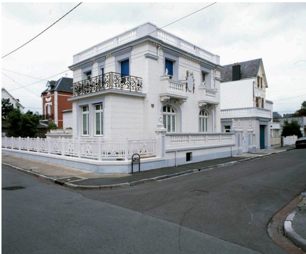
Albert Pouthier, auteur de la villa Castel au Touquet, Le Grand Trianon, construit par les architectes Albert Pouthier en collaboration avec Choppin d'Arnoville.
