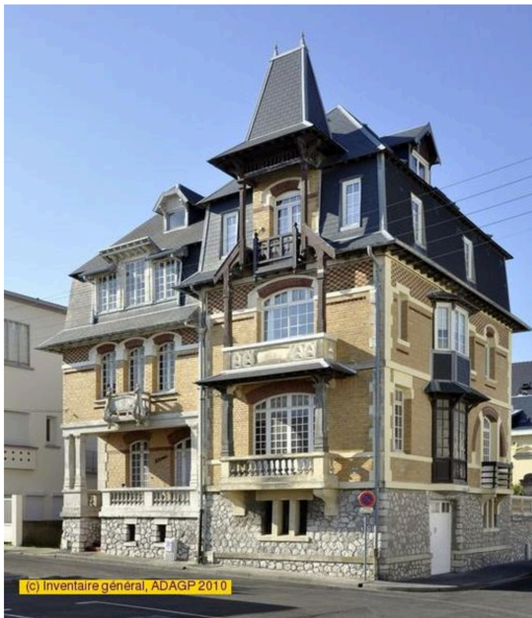
Vestige du groupe de villas, appelé la Pergola, angle rue Grosjean et d'Avesnes, signée de l'architecte amiénois Anatole Bienaimé.
