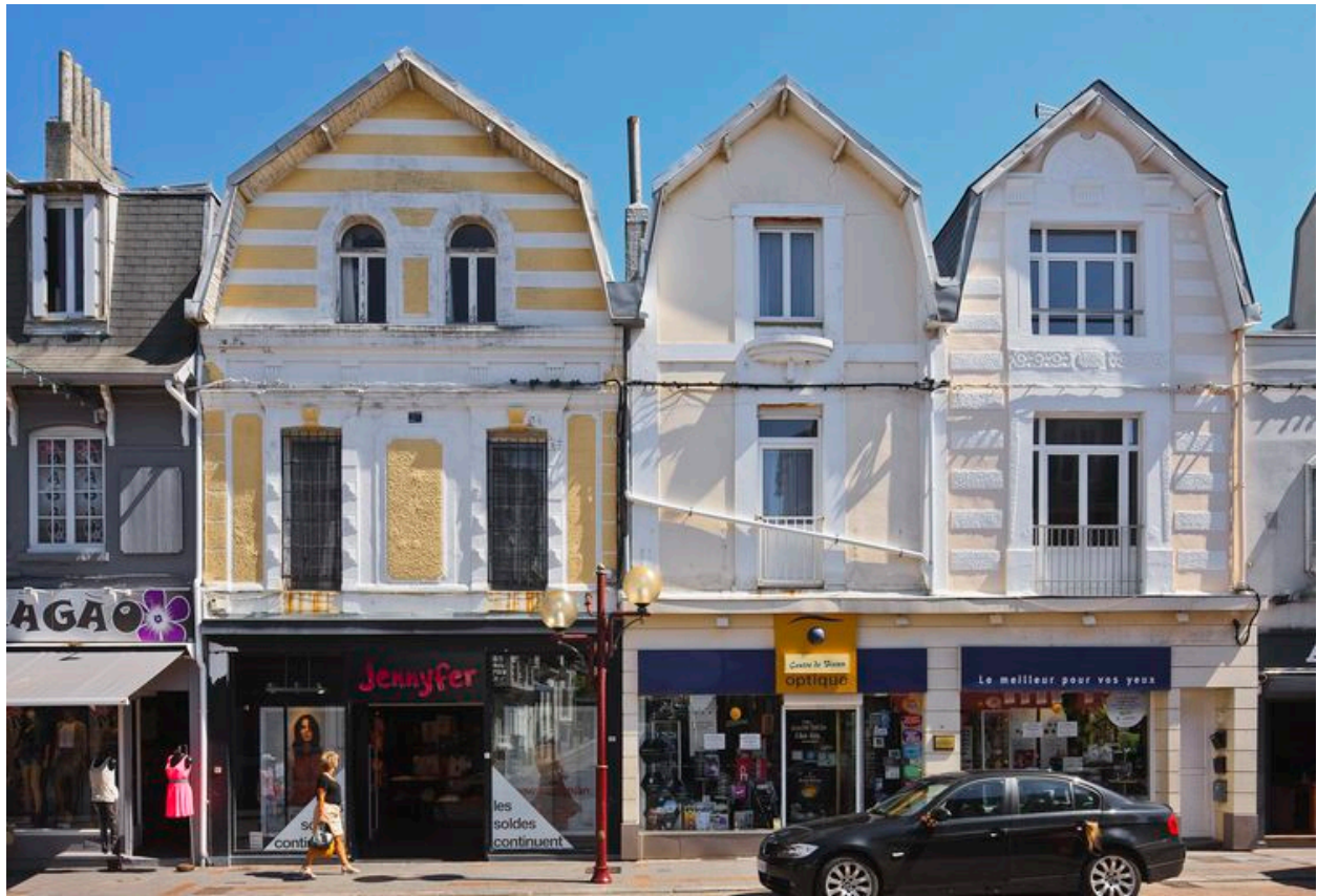
Alignement de chalets dans la rue Carnot.
