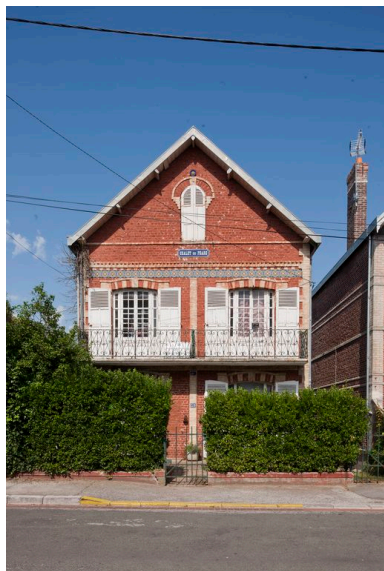
Chalet en brique, 16 rue Armand. Phot. Hubert Bouvet IVR31_20136200140NUCA
