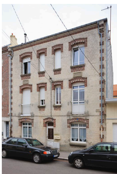
Immeuble 4 rue Simon-Dubois, s'apparentant aux maisons-doubles. Phot. Hubert Bouvet
