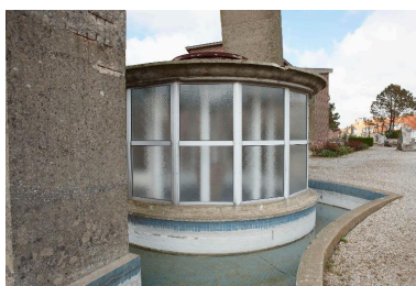
Balcons rue de la Mer ; Henri Valette et Gaston Bellêtre architectes. Phot. Thierry Petitberghien IVR31_20106200688NUCA
