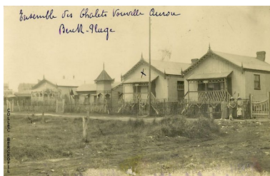
Chalets Nouvelle Aurore, constructions en matériaux légers. Phot. Sophie Luchier (reproduction) IVR31_20116201497NUCB
