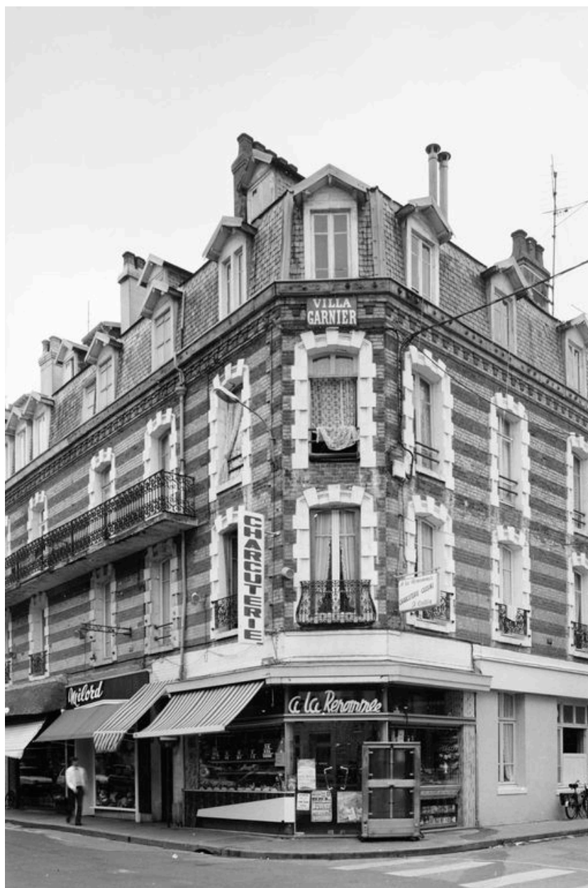
Vue générale de la Villa Garnier, immeuble 35 rue Carnot.
