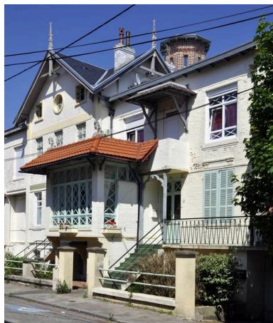
Immeuble rue du Dr Cayre. Phot. Thierry Petitberghien IVR31_20106201691NUCA
