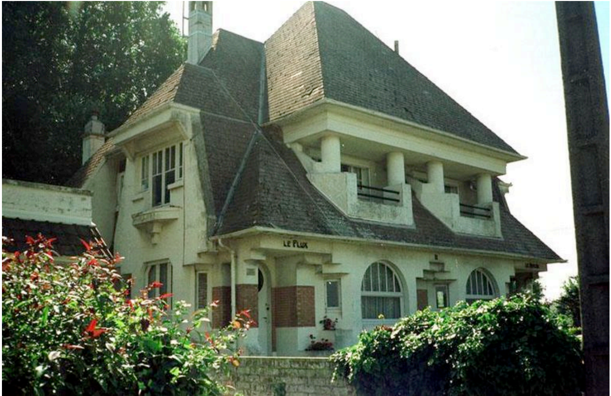
La villa Le Flux et le Reflux, construite par Chiossone et Michel.
