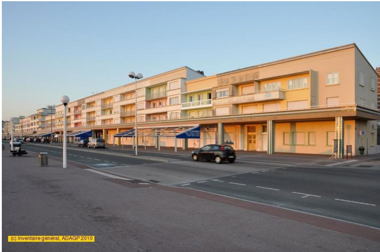
Immeubles de la digue reconstruite après la Seconde guerre mondiale.
