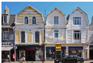
Alignement de chalets dans la rue Carnot. Phot. Hubert Bouvet IVR31_20136200185NUCA
