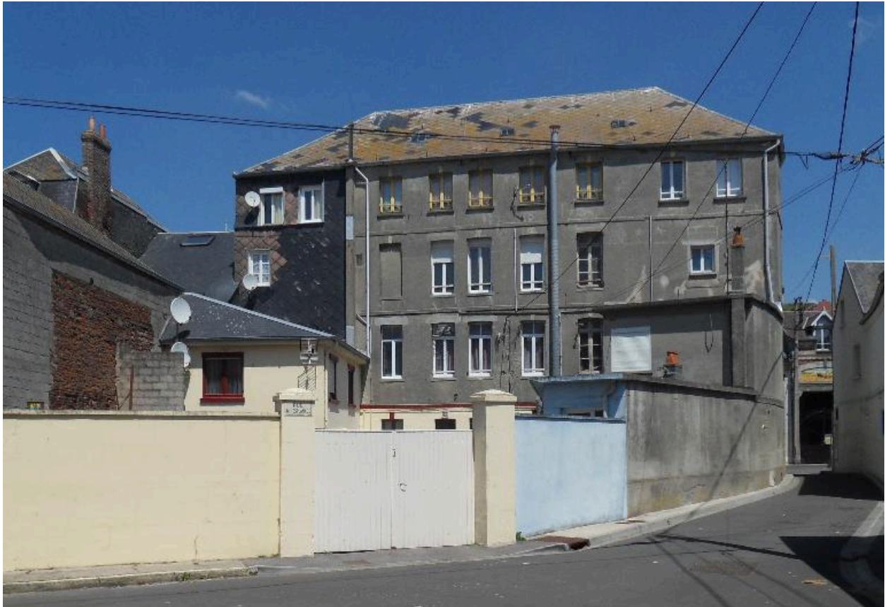
Vue de la façade postérieure.
