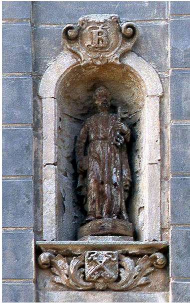
Détail de la niche en façade recevant une statuette de saint Pierre. Phot. Marie-Laure Monnehay-Vulliet IVR22_20058001160XA
