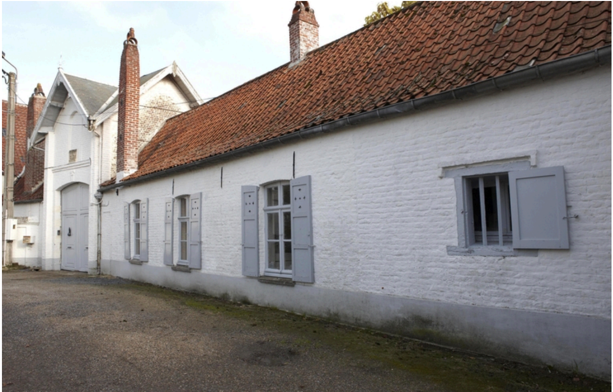
Le portail et l'aile abritant les communs transformés en logements ouvriers.
