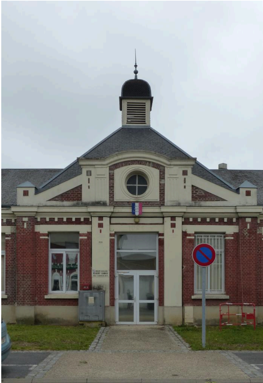
Le pavillon central du groupe scolaire.
