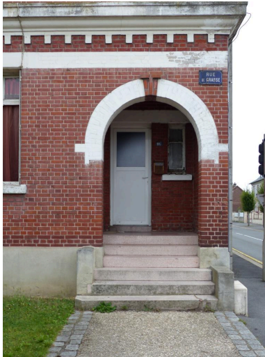
Le porche dans oeuvre des logements des enseignants. Phot. Isabelle Barbedor IVR32_20210205098NUCA
