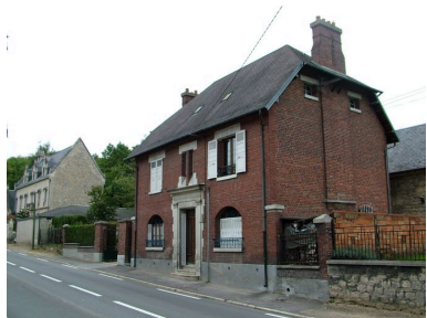
Vue générale. Phot. Inès Guérin IVR22_20050200626NUCA
