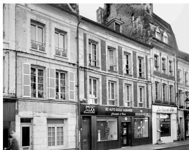
Vue de la façade sur rue. Phot. Thierry Lefébure IVR22_20020200826V
