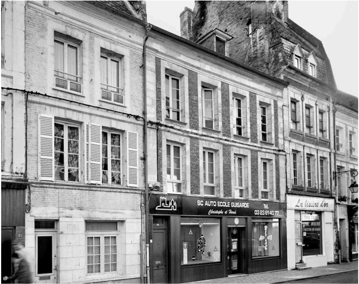
Vue de la façade sur rue.
