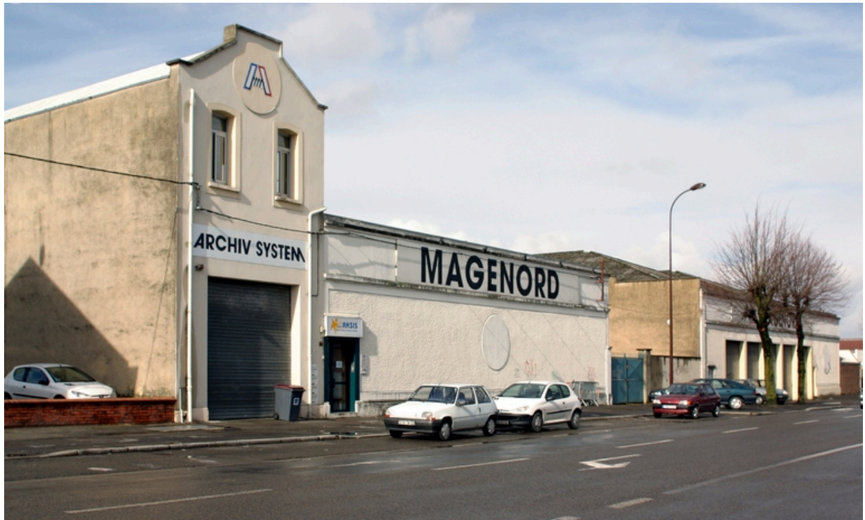
Façade antérieure de l'usine.
