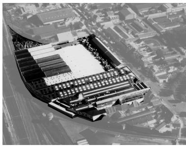
Vue aérienne du site en 1989. Phot. Pillet Frédéric, Autr. Phot'R IVR22_20050206284NUCA
