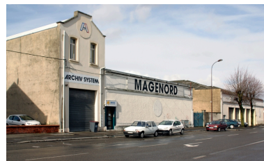
Façade antérieure de l'usine. Phot. Frédéric Pillet IVR22_20060205198NUCA
