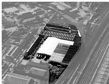
Vue aérienne du site en 1989. Phot. Pillet Frédéric, Autr. Phot'R IVR22_20050206283NUCA
