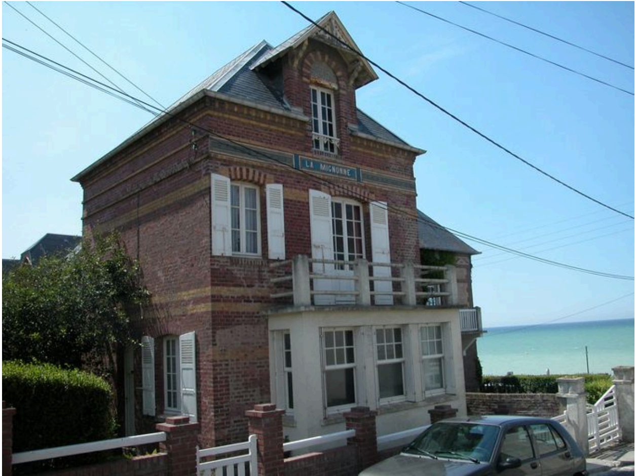
Vue d'ensemble depuis la partie haute de la rue.
