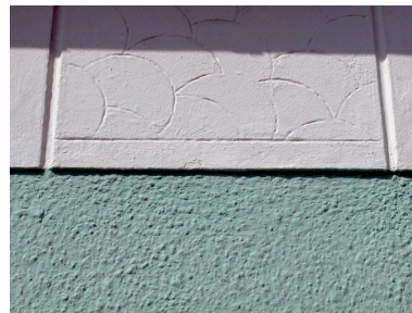
Détail du crépi et de la partie supérieure de l'élévation, avec motifs Art déco. Phot. Elisabeth Justome IVR22_20058002806NUCA
