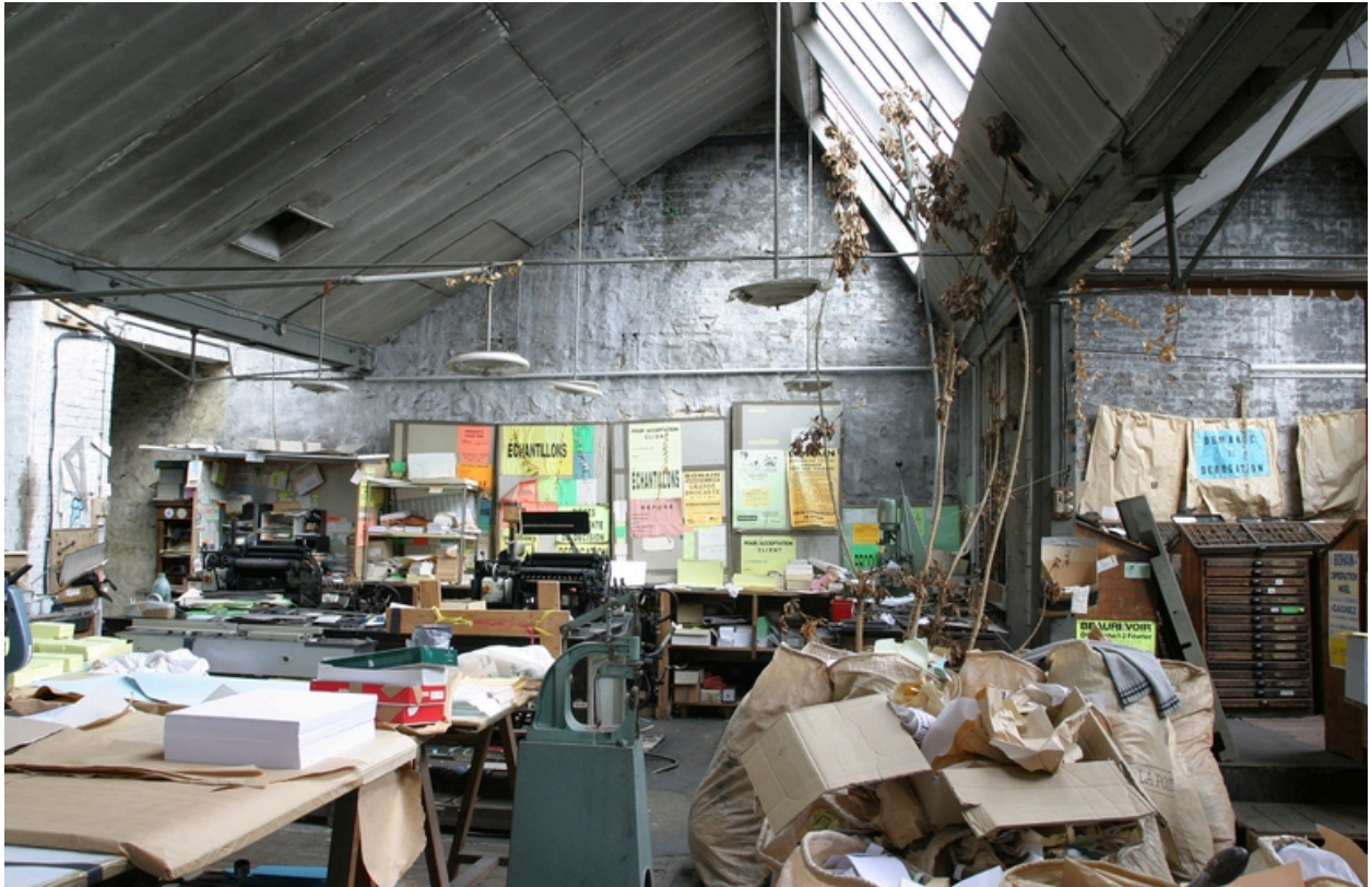
Atelier en rez-de-chaussée, couvert de sheds.
