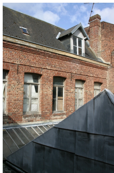
Façade postérieure des ateliers de la rue de Vesoul. Au premier plan, sheds de la cour intérieure. Phot. Frédéric Pillet IVR22_20050205997NUCA
