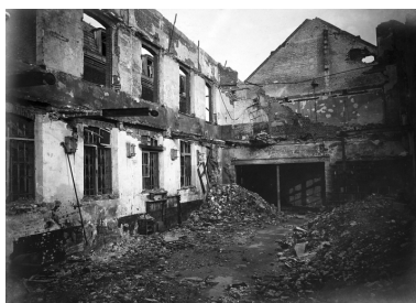
Ruines des ateliers de l'imprimerie Dupré & Thellier, place de l'Hôtel de Ville (AD Aisne). Phot. Pillet Frédéric
