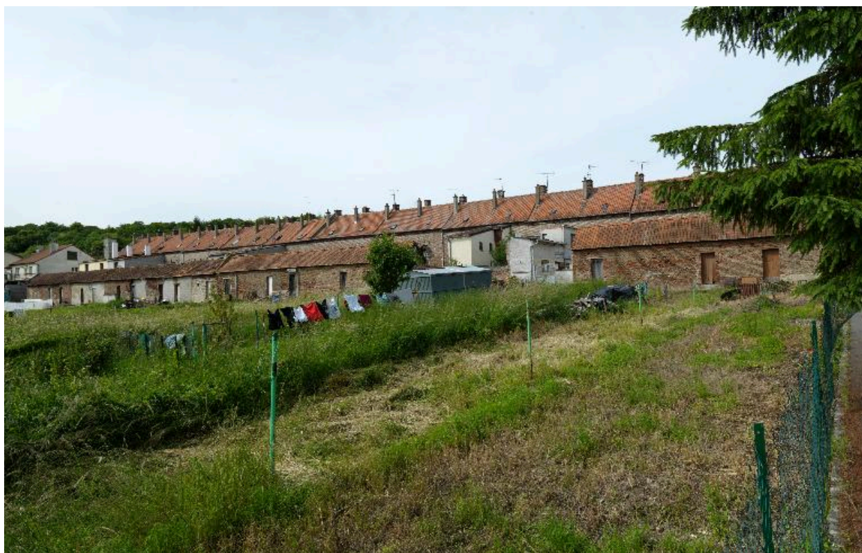
Vue d'ensemble postérieure des cours, remises et jardin de la cité ouvrière.
