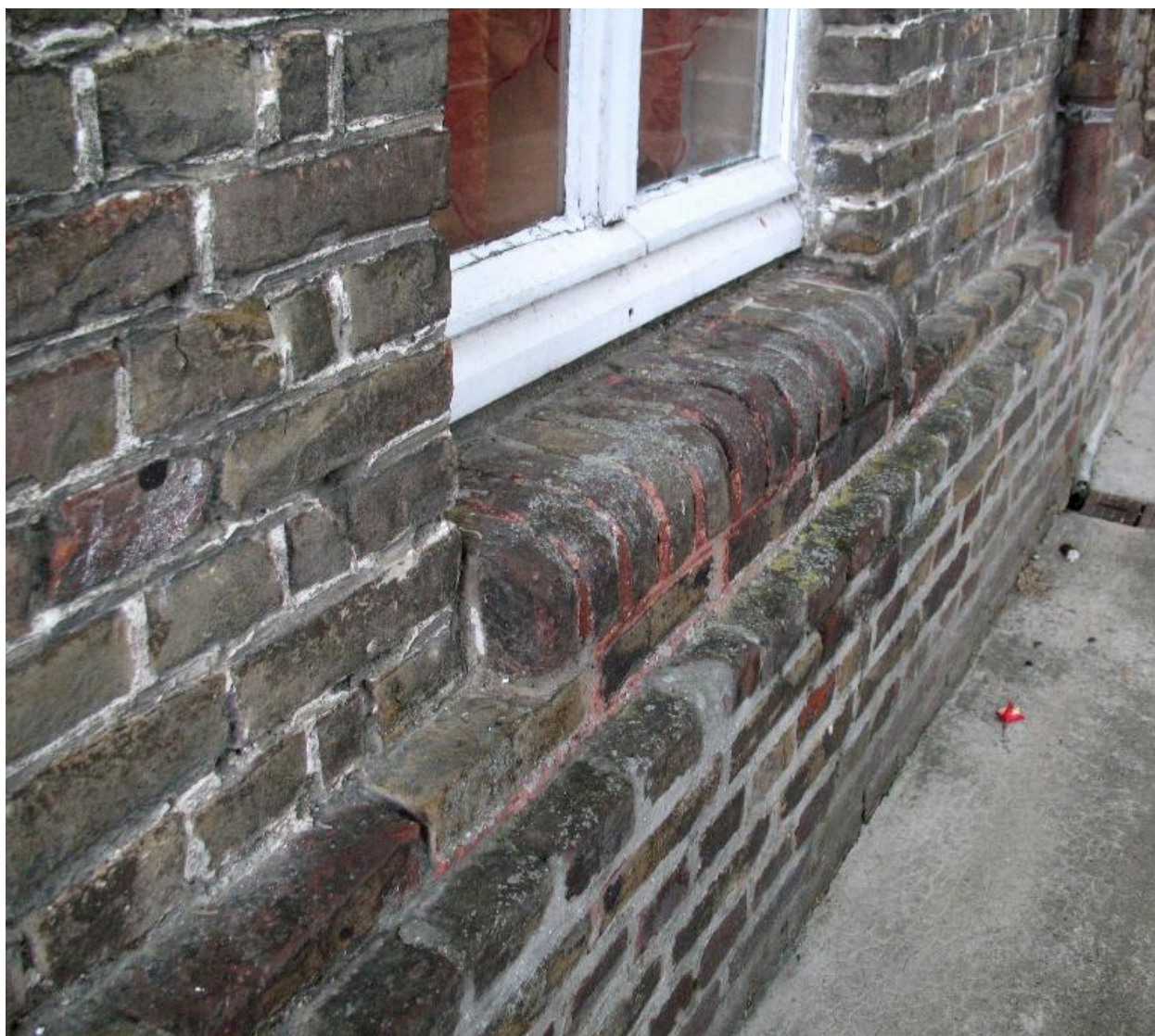
Détail d'un appui de fenêtre.
