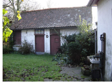
Vue des anciennes étables en fond de cour. Phot. Inès Guérin IVR22_20058005206NUCA
