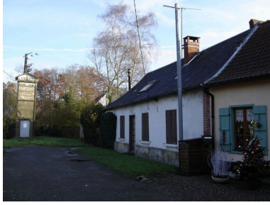
Vue d'ensemble. Phot. Inès Guérin IVR22_20058005204NUCA
