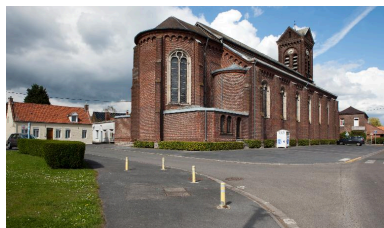
Vue générale du bas-côté sud et le chevet. Phot. Pierre Thibaut IVR31_20125901645NUCA
