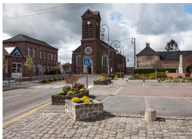
Vue générale de l'église et la place. Phot. Pierre Thibaut IVR31_20125901611NUCA
