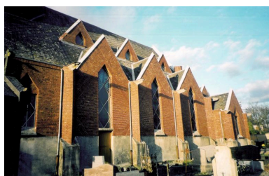
Façade latérale. Phot. Gilles-Henri Bailly IVR22_20158005742NUCA
