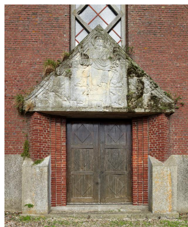
Le portail principal. Phot. Marie-Laure Monnehay-Vulliet IVR22_20158000705NUC2A
