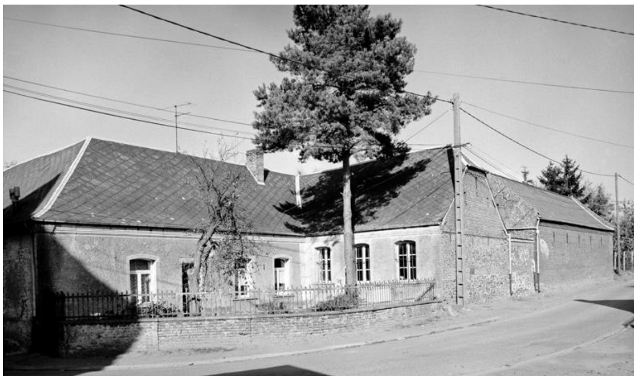
Vue partielle du logis, et de l'élévation sur rue de l'étable.
