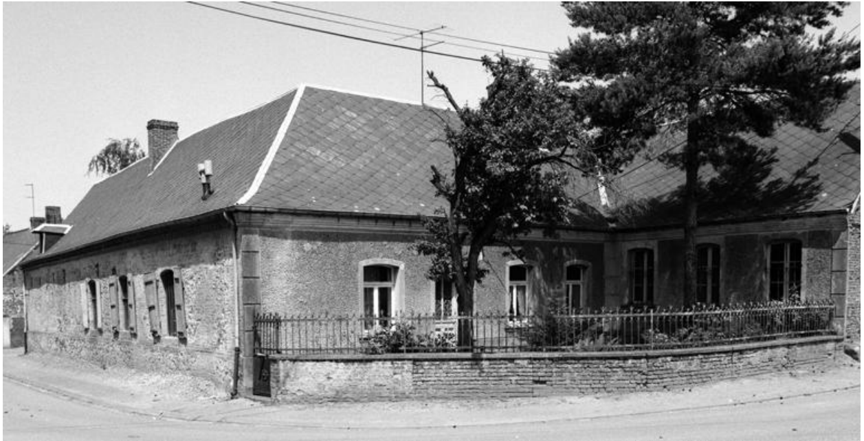
Vue d'ensemble du logis, depuis le sud.
