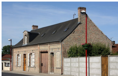
Vue d'ensemble. Phot. Bertrand Fournier IVR22_20098005122NUCA
