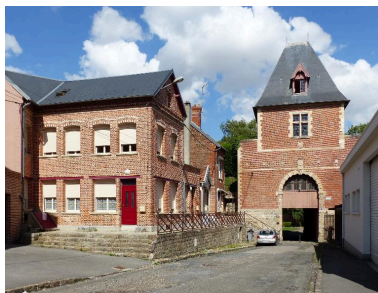
Vue de situation, depuis la rue Saint-Fursy. Phot. Isabelle Barbedor IVR32_20178005243NUCA
