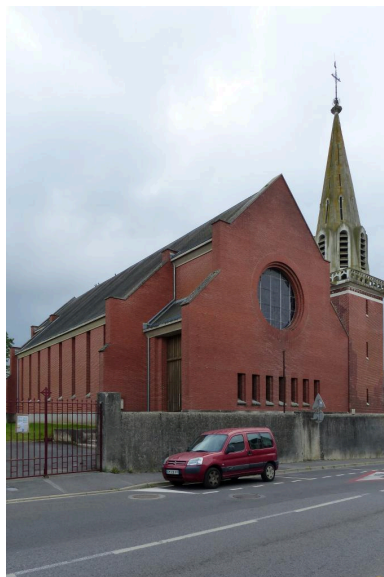
Vue générale, depuis le nord. Phot. Isabelle Barbedor IVR32_20210205132NUCA
