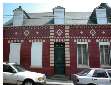
Maison portant la date 1868, 96 rue André-Dumont. Phot. Elisabeth Justome IVR22_20058003162NUCA
