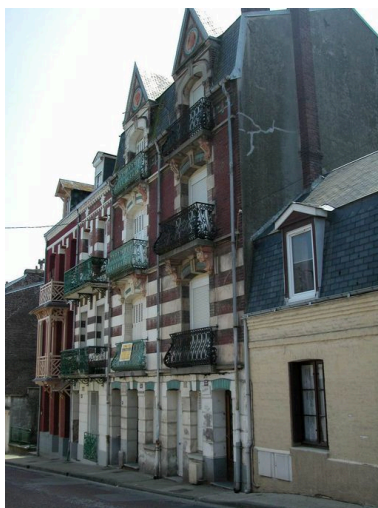
Ensemble de maisons à plusieurs entrées au rez-de-chaussée (27 à 33 rue Pasteur), dont Villa Pierre Lefort au n°29. Phot. Elisabeth Justome IVR22_20058003166NUCA
