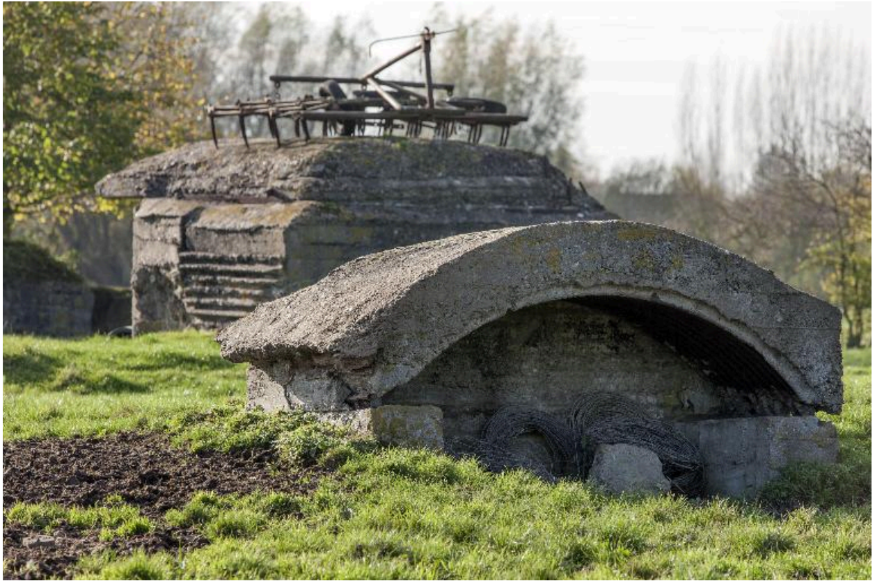
L'édifice, dans le fond, à droite en 2013
