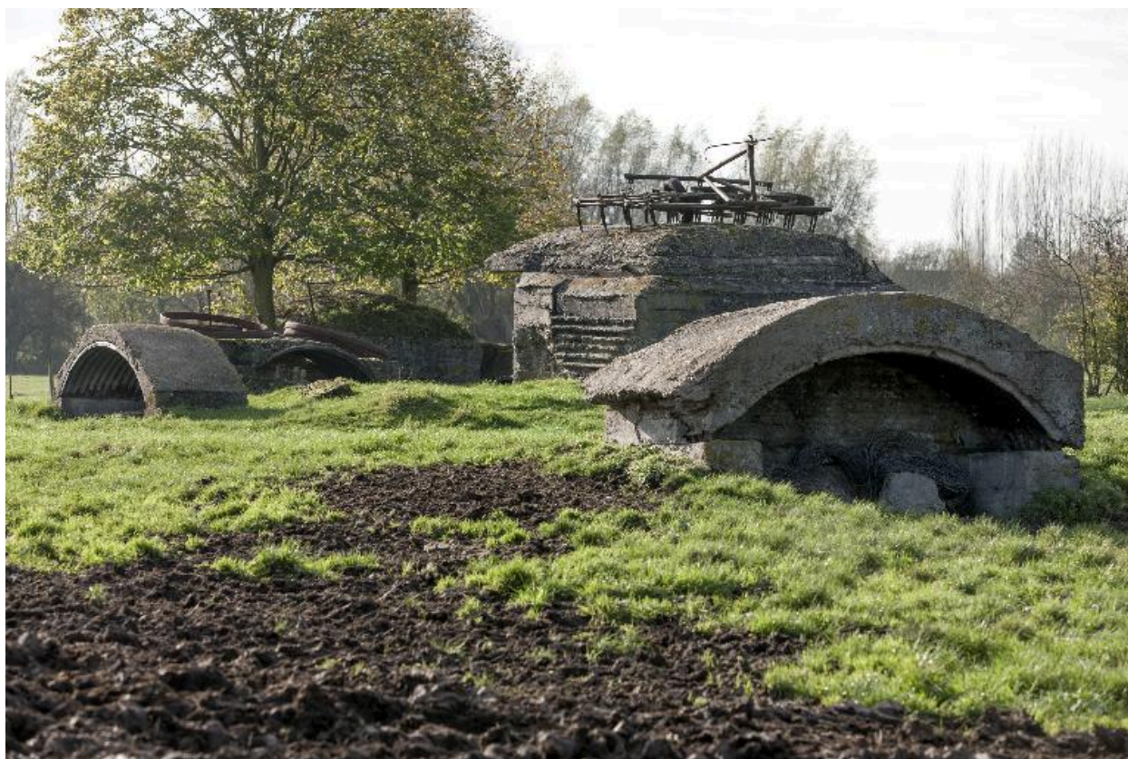
L'édifice, dans le fond, à droite en 2013
