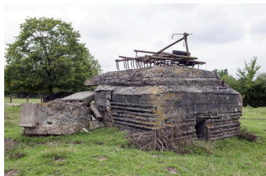
La casemate en 2015, vers l'est Phot. Pierre Thibaut IVR31_20155901468NUCA
