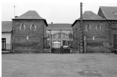
Portail, conciergerie. Phot. Thierry Lefébure IVR22_19888000304Z
