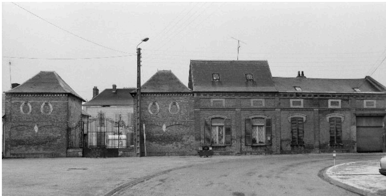
Vue des bâtiments sur la rue, pavillons d'entrée et logements.
