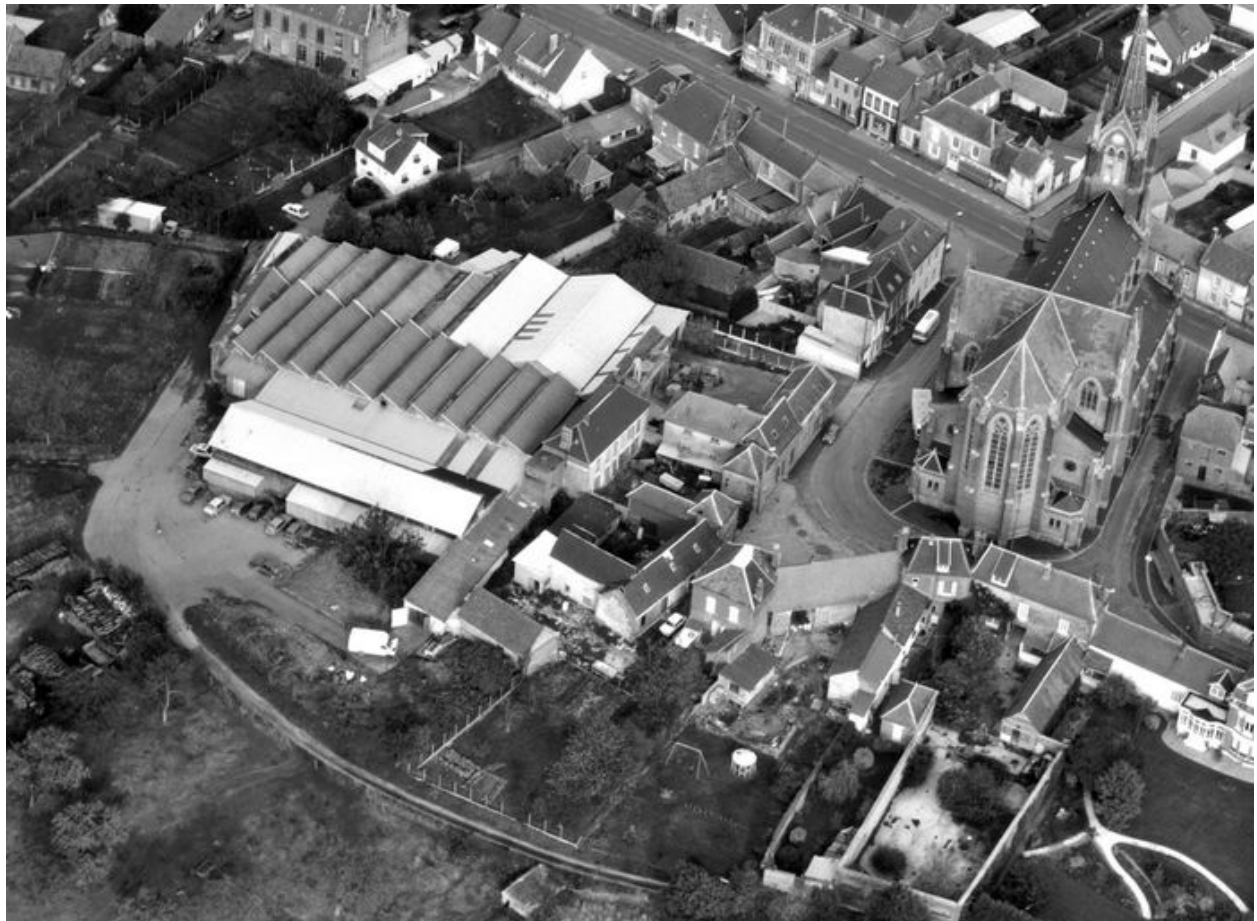
Vue aérienne, flanc ouest.
