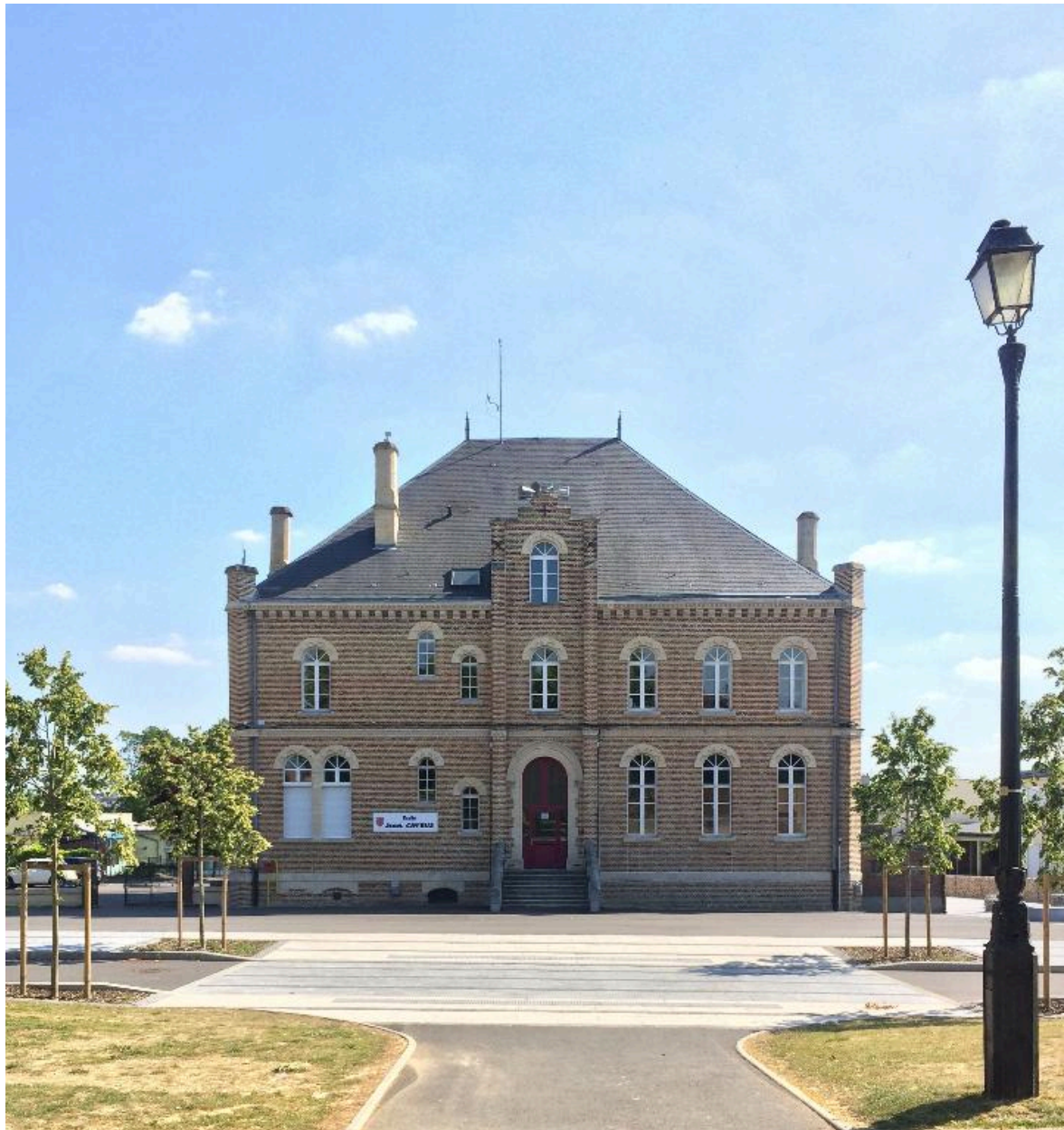
Vue de la façade nord.
