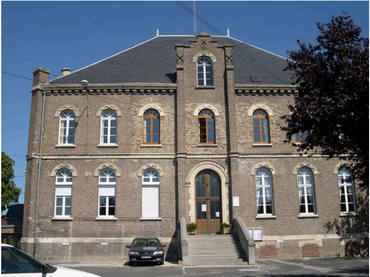
Vue de la façade sud.
