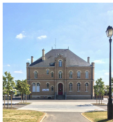
Vue de la façade nord. Phot. Isabelle Barbedor IVR32_20178005072NUCA
