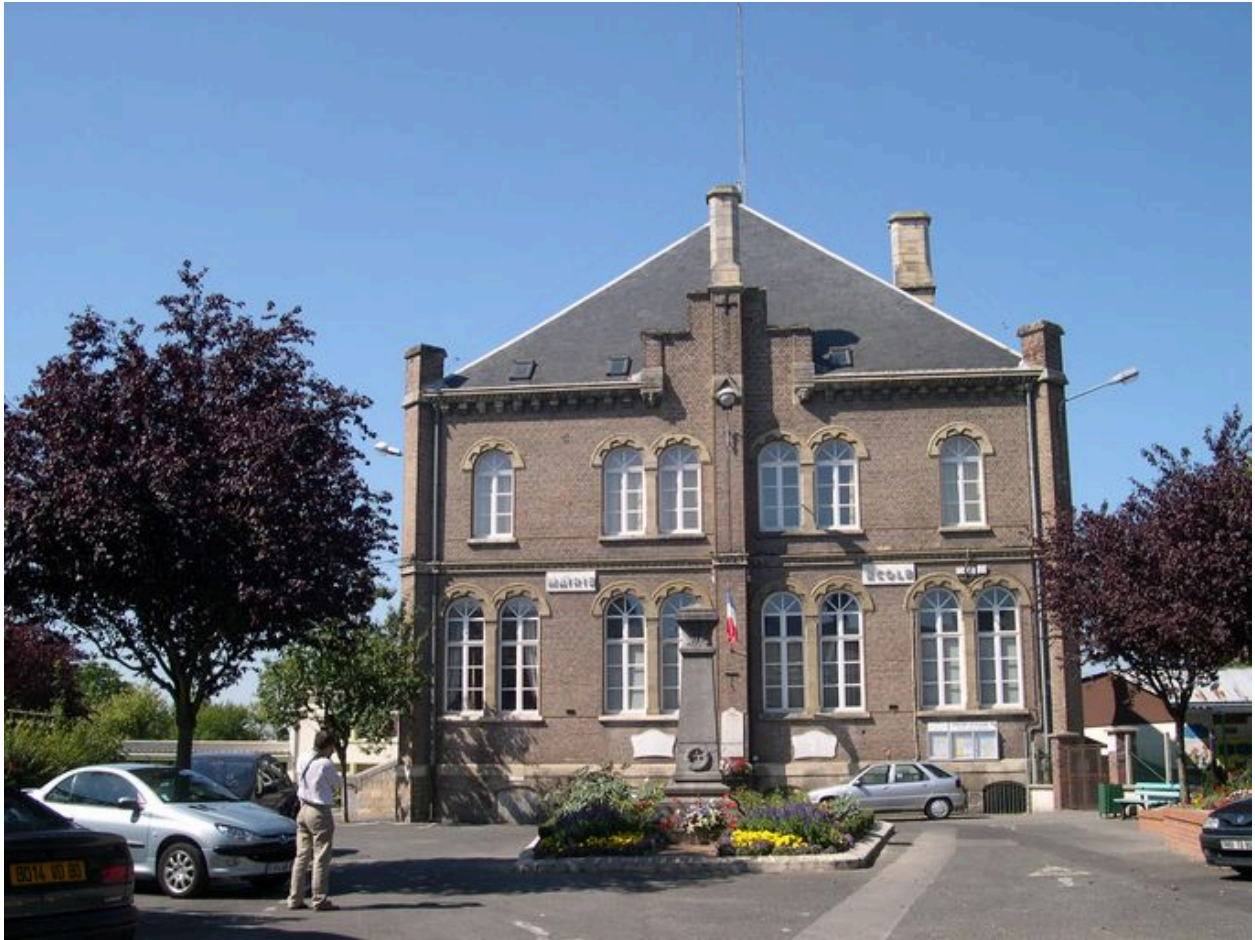
Vue générale, depuis l'est.
