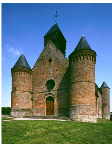
Vue générale sud-ouest. Phot. Thierry Lefébure IVR22_19930200596VA
