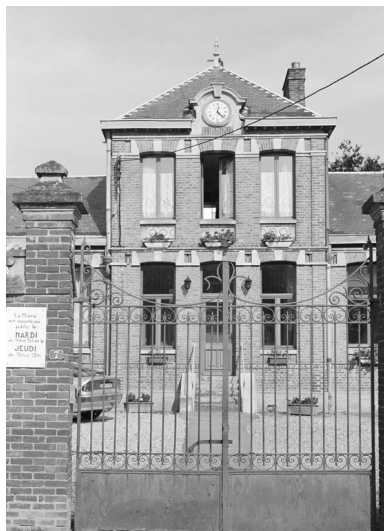
Façade antérieure. Phot. Judith Förstel IVR22_19988001097Z
