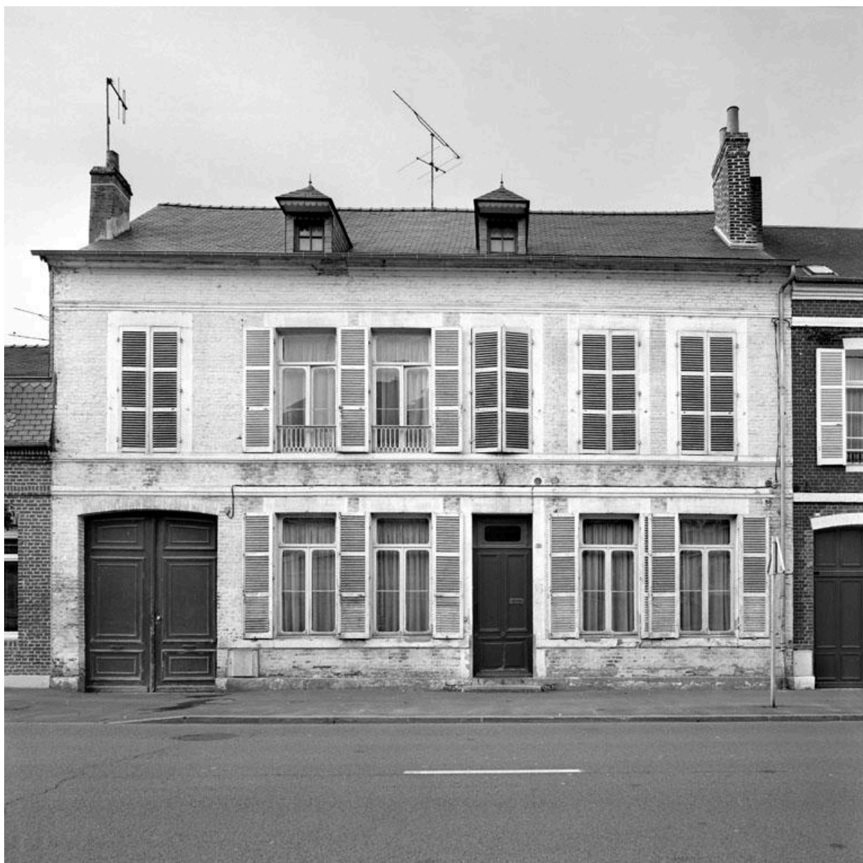
Vue de la façade sur rue.
