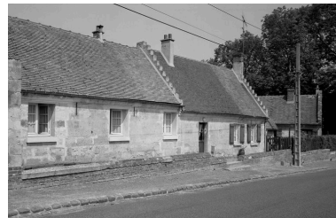
Logements de domestiques. Elévation est. Phot. Jean-Michel Perrin IVR22_19856000739X
