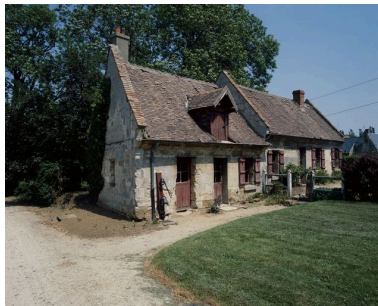
Logements de domestiques. Phot. Jean-Michel Perrin IVR22_19856000710XA
