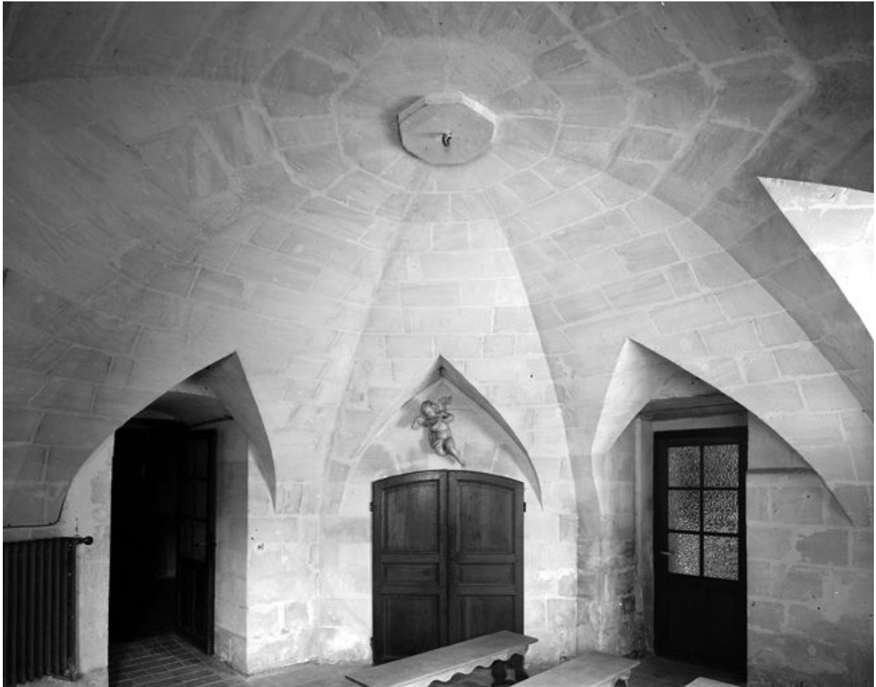
Vue intérieure : voûte de l'entresol.
