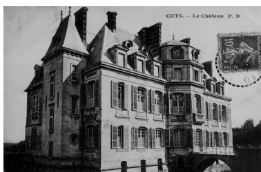
Elévation postérieure, avant 1914 (AP). Phot. Jean-Michel Périn IVR22_19856000190XB
