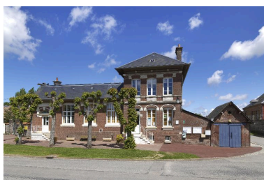
L'école-mairie. Phot. Thierry Lefébure IVR22_20158000411NUC2A
