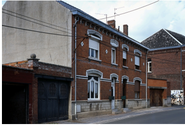
Les deux maisons en série. Phot. Pierre Thibaut IVR31_20085901063XA
