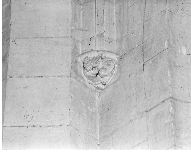
Culot, première travée, angle droit. Phot. Thierry Lefébure IVR22_19940200958X
